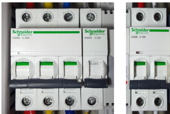
รูปที่ 4.32 อุปกรณ์ตัดกระแสไฟฟ้า (Circuit Breaker)
