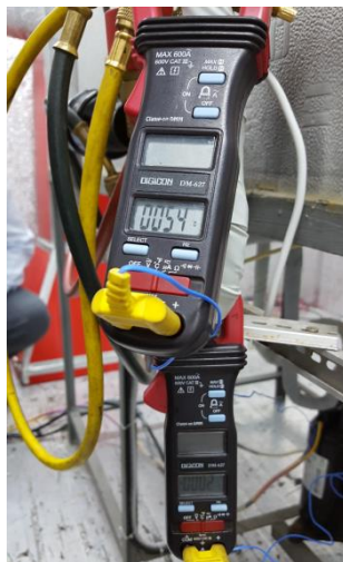
รูปที่ 5.14 แสดงการตรวจวัดอุณหภูมิทางด้านดูดและด้านจ่าย
