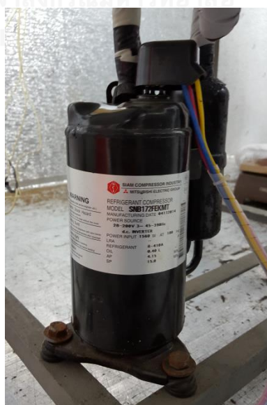
รูปที่ 4.25 แสดงการติดตั้งคอมเพรสเซอร์
