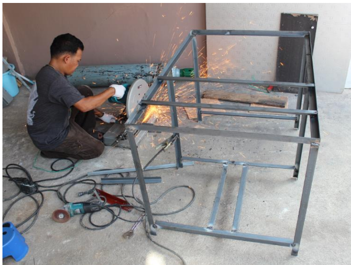
รูปที่ 4.22 แสดงการตัดเหล็กเพื่อเชื่อมเป็นฐานของเครื่องฮีทปั๊ม
