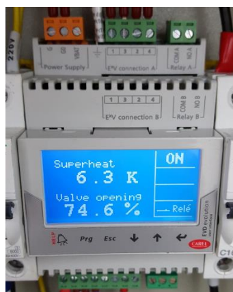
รูปที่ 5.15 ชุดควบคุมวาล์วปรับแรงดัน
