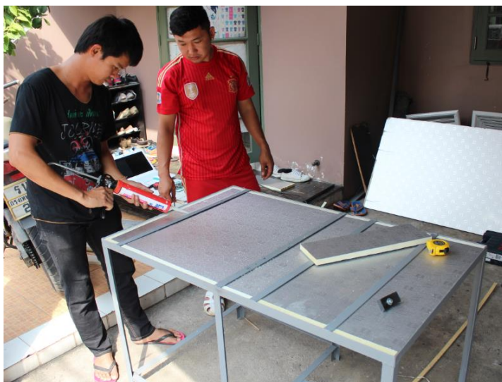
รูปที่ 4.24 แสดงการยิงกาวซิลิโคนบริเวณรอยต่อของแผ่นโฟม PID
