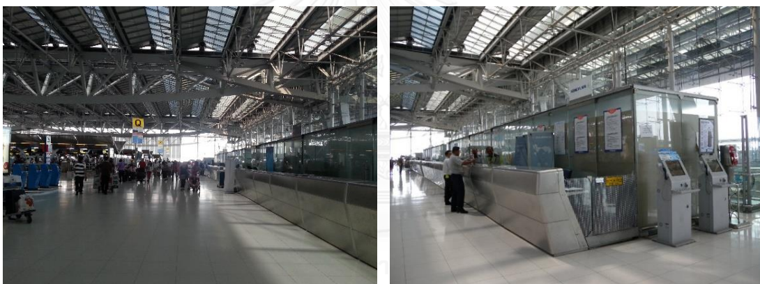
รูปที่ 3.28 การรื้อย้ายเคาน์เตอร์ขายบัตรโดยสาร อาคารผู้โดยสาร ชั้น 4
