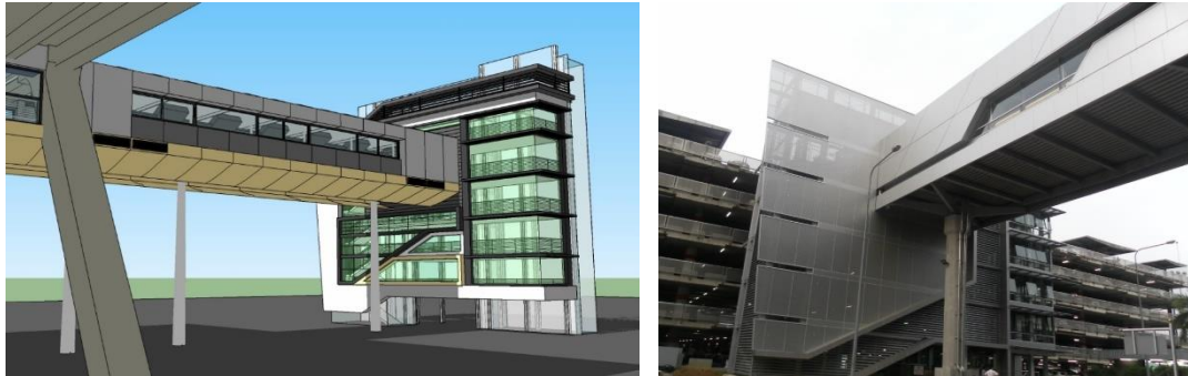
รูปที่ 3.33 การติดตั้งผนังเพื่อป้องกันฝน ทางเชื่อมเข้าอาคารผู้โดยสาร ชั้น 3
