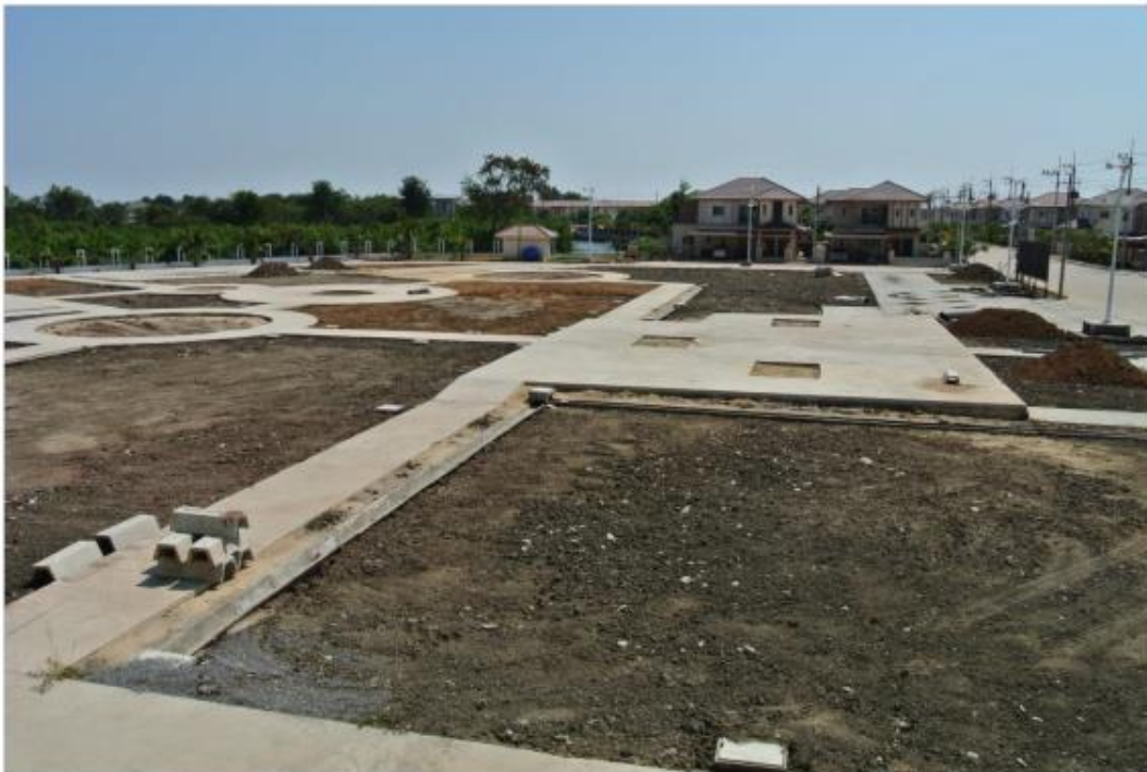
ภาพที่ 3- 18 พื้นที่ส่วนกลาง (อยู่ระหว่างการก่อสร้าง) ในโครงการไอสิฟพาร์ค
