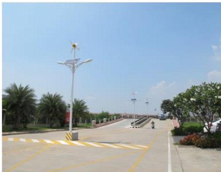
ภาพที่ 4- 1 เสาไฟถนนโซล่าเซลล์ในโครงการ
