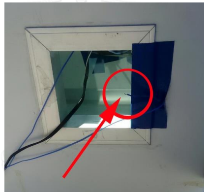
ภาพที่ 3.6: จุดวัดอุณหภูมิช่องอากาศเข้า
