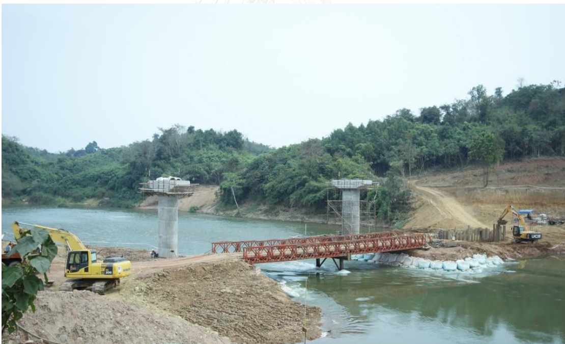
ภาพที่ 4-28 พื้นที่บริเวณโครงการน้ำเจียบ 1 ระหว่างดำเนินการก่อสร้าง (ที่มา: Nam Ngiep 1 Power Company, 2016)
