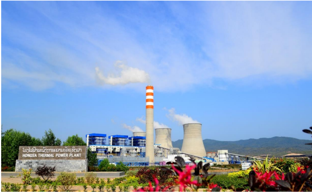
ภาพที่ 4-15 พื้นที่บริเวณโรงไฟฟ้าพลังความร้อนหงสา (ที่มา: Hongsa Power Company Limited, 2016)
