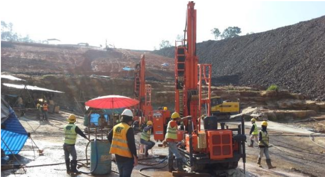
ภาพที่ 4-23 พื้นที่บริเวณโครงการเซเปียน-เซิน้าน้อย ระหว่างดำเนินการก่อสร้าง (ที่มา: ไรท์ทันเน็ลลิง, 2557)
