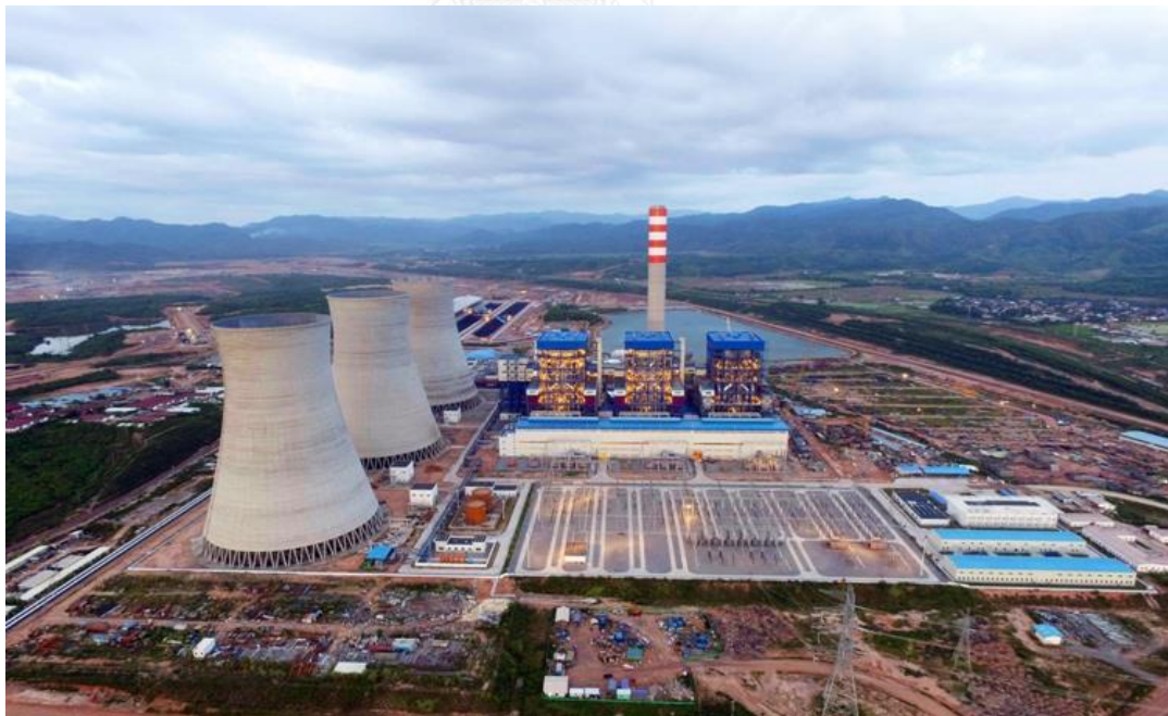
ภาพที่ 4-16 พื้นที่บริเวณโรงไฟฟ้าพลังความร้อนหงสา (ที่มา: Hongsa Power Company Limited, 2016)
