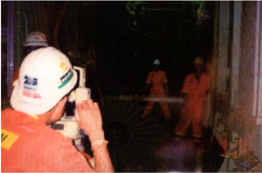
รูปที่ 3.5 ตรวจสอบศูนย์กลางอุโมงค์
