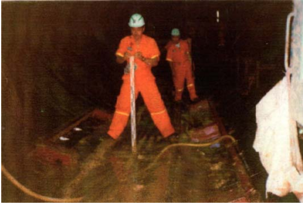
รูปที่ 3.7 ตรวจสอบค่าระดับที่ Invert ของผนังอุโมงค์
