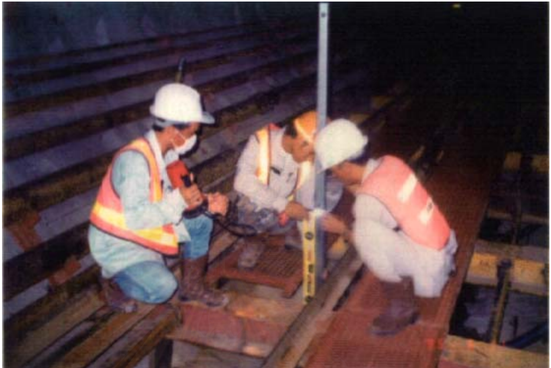
รูปที่ 3.21 Wriggle Survey บริเวณ Inverts ของผนังอุโมงค์
