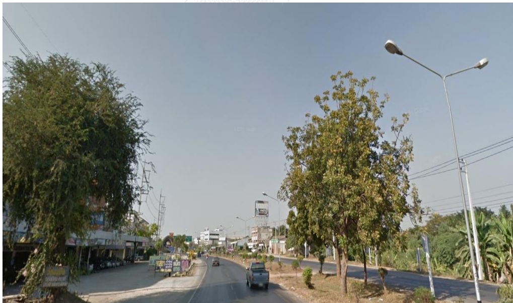
รูปที่ 3.7 แสดงทางหลวงแผ่นดินหมายเลข 323 อำเภอท่ามะกา จังหวัดกาญจนบุรี เป็นถนนขนาด 4 ช่องจราจร
