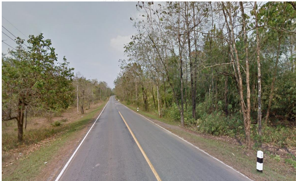
รูปที่ 3.15 แสดงทางหลวงแผ่นดินหมายเลข 323 ในอำเภอทองผาภูมิ จังหวัดกาญจนบุรี เป็นถนนขนาด 2 ช่องจราจร
