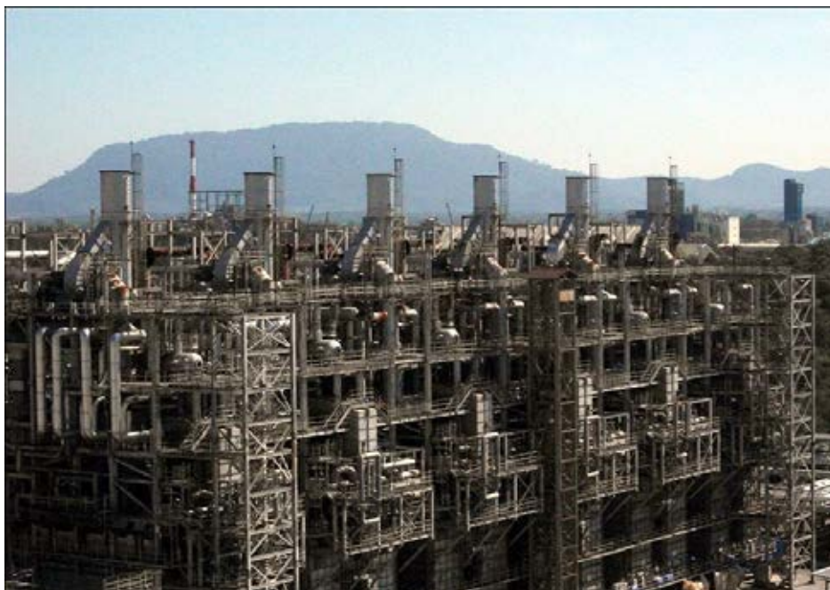
รูปที่ จ.1 Cracking furnaces (F0101-F0601)
