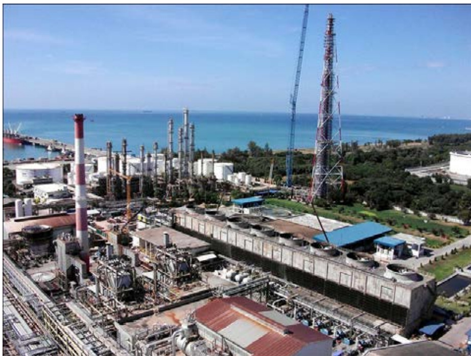
รูปที่ ๑.5 โรงงานไฟฟ้าพลังงานความร้อนร่วมที่สนับสนุนกระบวนการผลิตโอเลฟินส์
