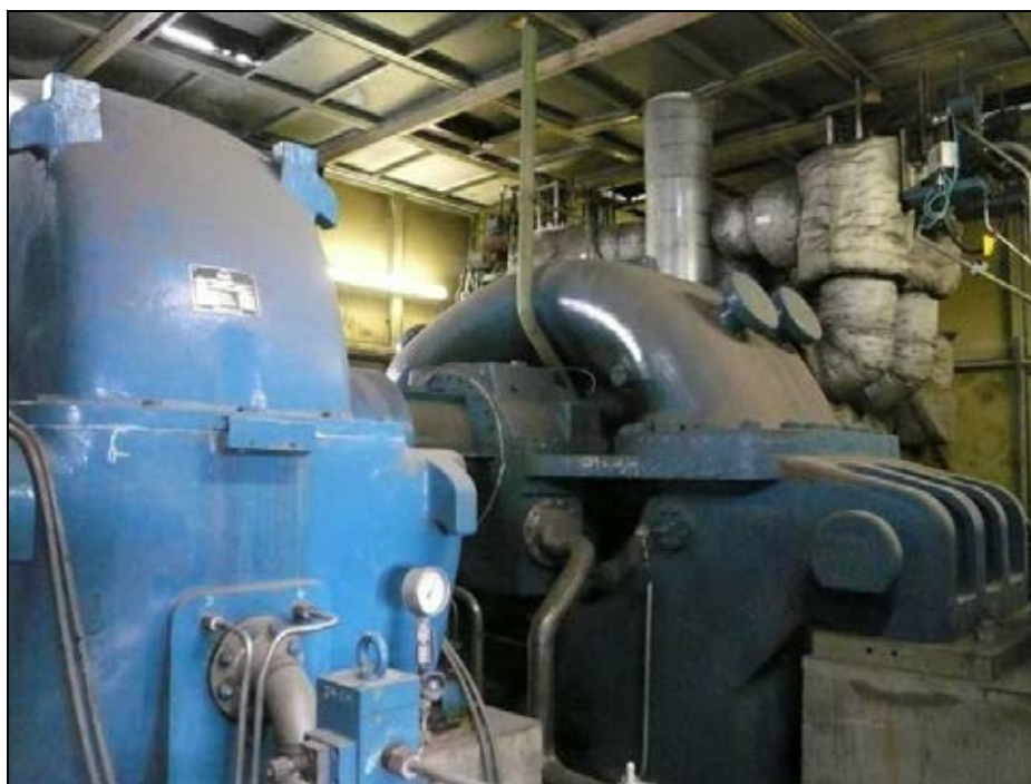
รูปที่ ๑.๑๐ ภายใน Turbine House กังหันไอน้ำ X8201 (Steam Generator turbine)
