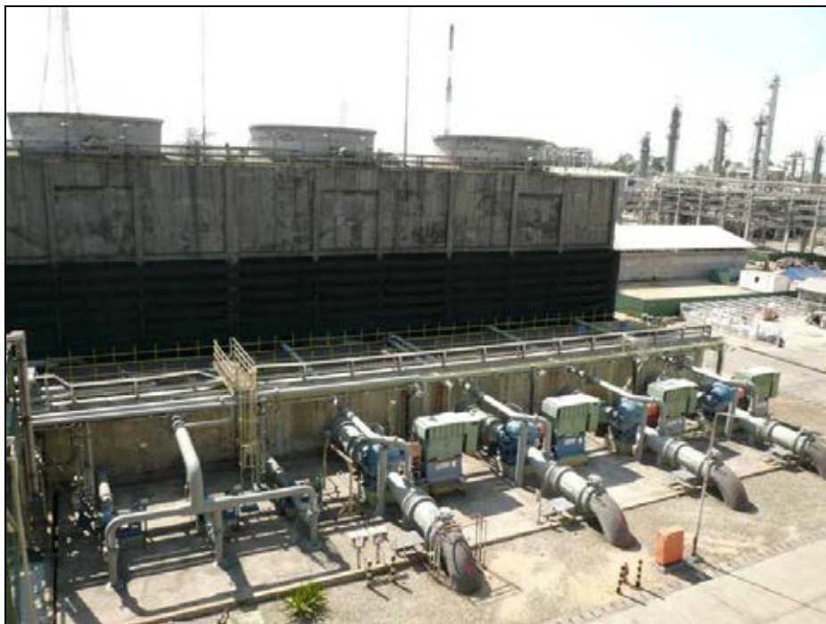
รูปที่ จ.19 หอน้ำหล่อเย็น (Cooling Tower)
