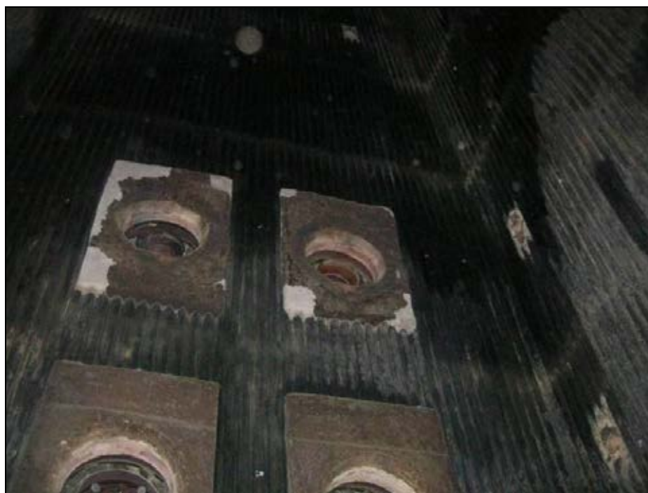
รูปที่ จ.12 ภายในห้องเผาไหม้หม้อต้มไอน้ำ (Boiler)
