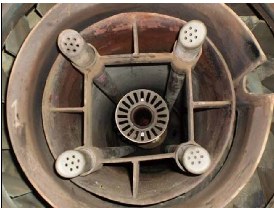
รูปที่ ๑.14 ภายในหัวเผาไหม้ชนิด Oil & Gas
