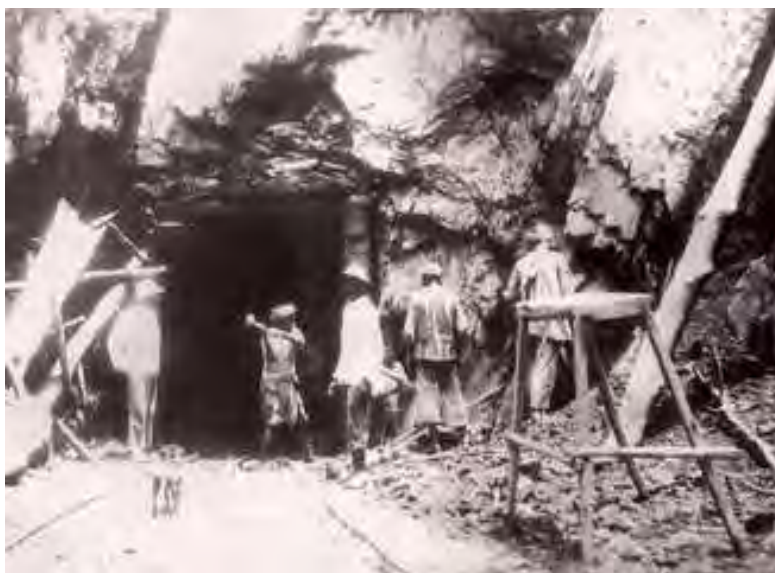
ภาพที่ 14 การขุดเจาะอุโมงค์ส่วนหนึ่งของทางรถไฟสายเหนือ
