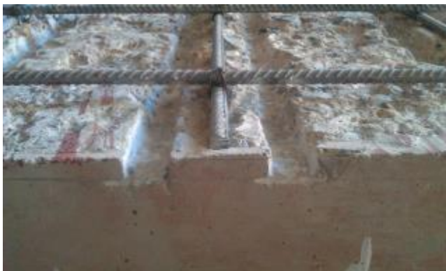
ภาพที่3-11 ลักษณะร่องที่เจาะเสร็จเรียบร้อยแล้ว
