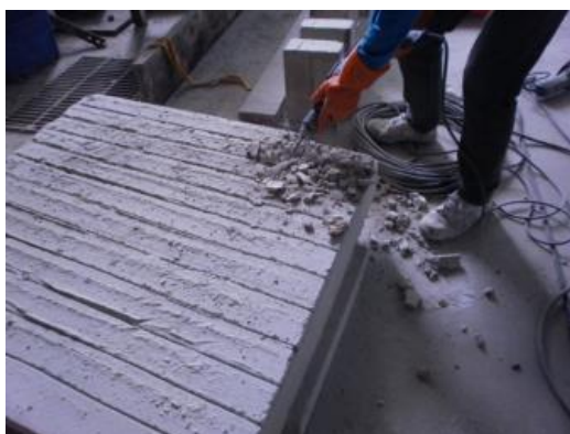
ภาพที่3-8 การสกัดคอนกรีตที่ได้รับความเสียหายจากเพลิงไหม้
