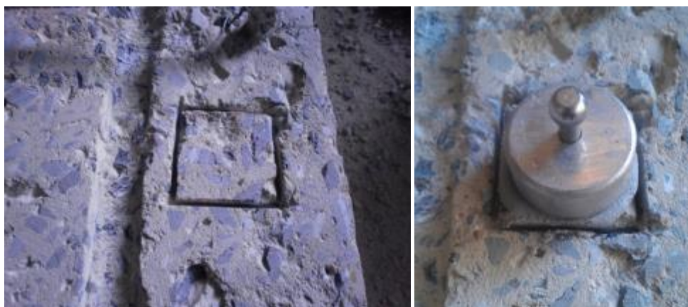
ภาพที่ 3-9 การติดตั้งลูกเหล็ก
