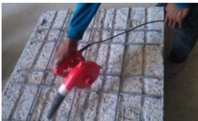
ภาพที่3-12ใช้เครื่องเป่าไล่สิ่งสกปรกและเศษคอนกรีตที่หลุดล่อนออกไป
