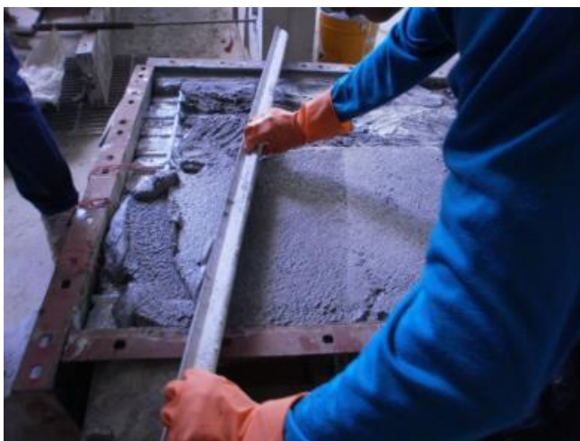
ภาพที่3-18 การฉาบผิววัสดุซ่อมให้เรียบ
