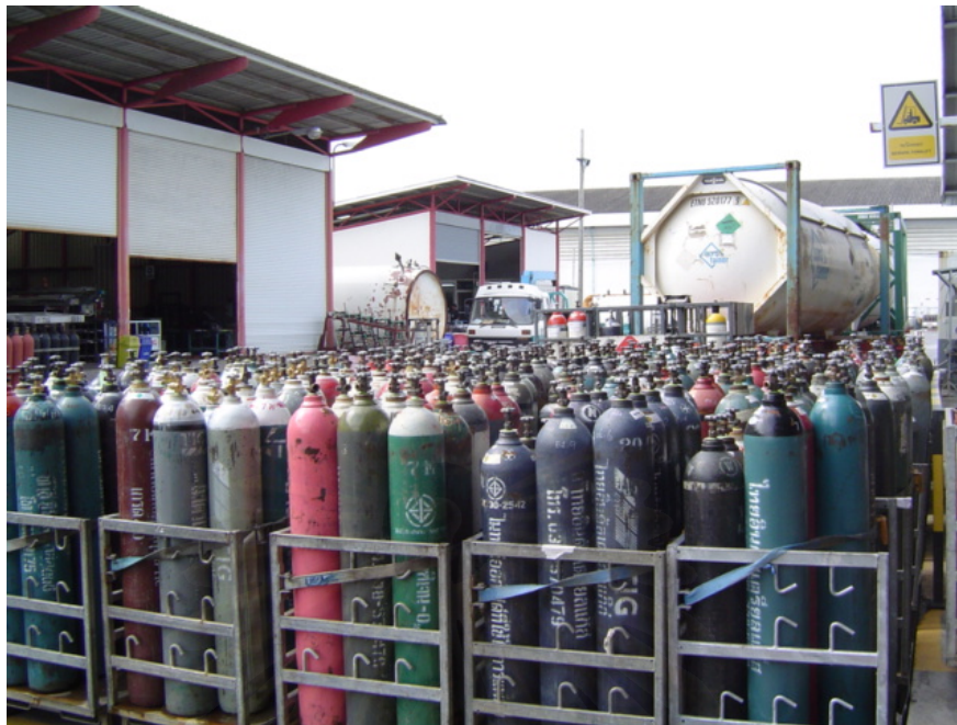
รูปที่ 3-2 การวางท่อในโรงงานปัจจุบัน
