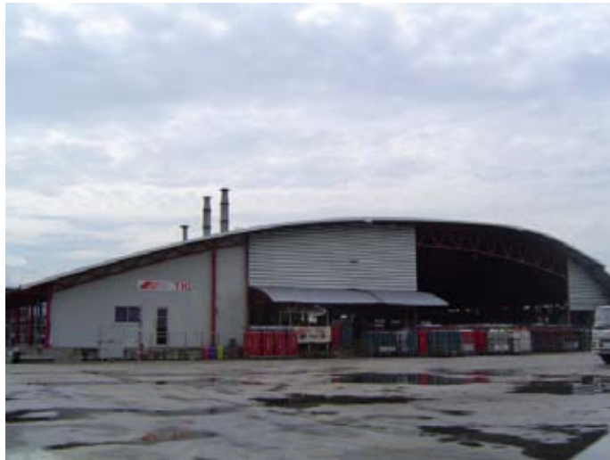
รูปที่ 3-4 บริเวณลานจอดรถขนส่งปัจจุบัน
