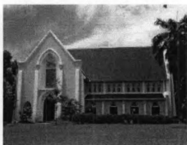
โบสถ์ภายในโรงเรียนปรีณสรอวยลวิทยาลัย เคยได้รับรางวัลอาคารอนุรักษ์ ดีเด่น ของสมาคมสถาปนิกสยามในพระบรมราชูปถัมภ์ ในปี พ.ศ.2539
