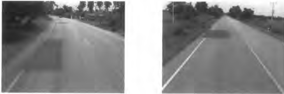
รูปที่ 3.2 รอยปะชอมบนพื้นผิวทางแอสฟัลต์ที่มีแสงสว่างไม่สม่ำเสมอ
