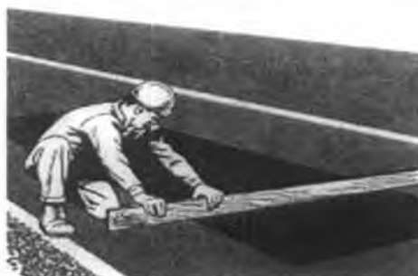
(ฉ) ตรวจสอบระดับผิวด้วยไม้บรรทัด
