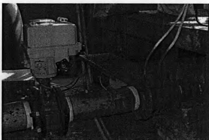
รูปที่ 3.4 วาล์วไฟฟ้ารูปผีเสื้อและ orifice
