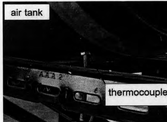
รูปที่ 4-7 แสดงจุดที่ติดตั้งหัววัดเทอร์โมคัปเปิลในถังพักอากาศ
