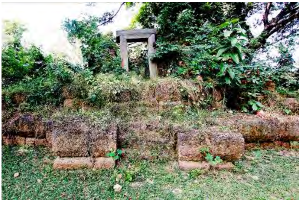
รูป 1.6 แสดงบริเวณด้านหน้าปราสาททอง โดยประกอบด้วยฐานไพทีที่ทำด้วยศิลาแลง และ ซุ้ม ประตูด้านหน้า
