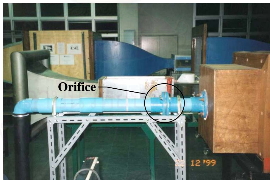
รูปที่ 4.20 ภาพแสดงชุด Orifice ที่ติดตั้งบริเวณทางเข้าของอุโมงค์ลม
