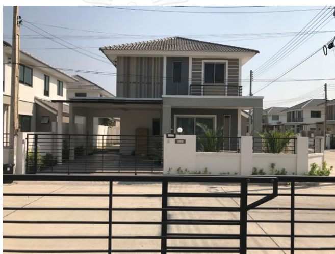
ภาพที่ 10 บ้านเดี่ยวสองชั้น โครงการแฟมิลี่ ซิตี้ พานทอง บริษัท ไลฟ์แอนดส์ฟิวเจอร์ จำกัด
