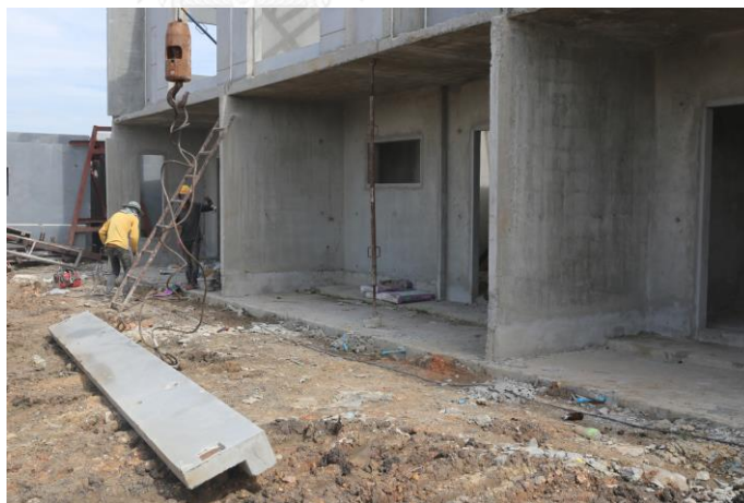
ภาพที่ 7 การประกอบติดตั้งชิ้นส่วนคอนกรีตสำเร็จรูป
