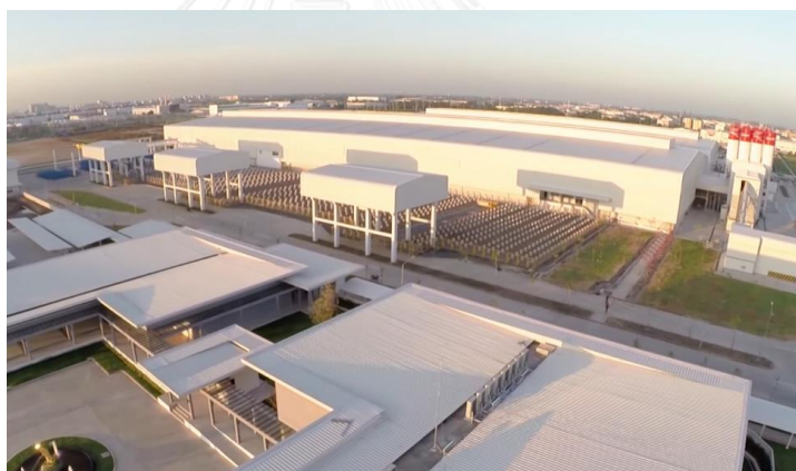
ภาพที่ 13 โรงงานผลิตชิ้นส่วนคอนกรีตสำเร็จรูป นวนคร บริษัท พุกษา เรียลเอสเตท จำกัด (มหาชน) ที่มา บริษัท พุกษา เรียลเอสเตท จำกัด(มหาชน)
