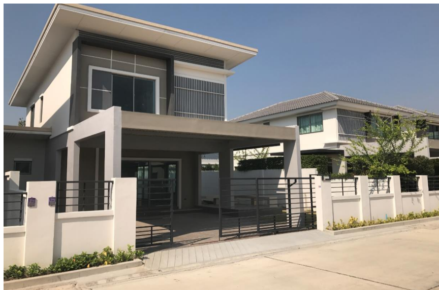
ภาพที่ 2 บ้านที่สร้างด้วยชิ้นส่วนคอนกรีตสำเร็จรูป
