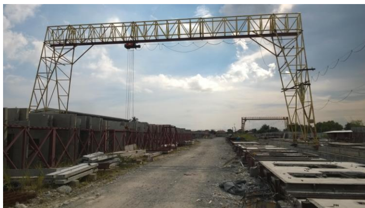
ภาพที่ 31 สายการผลิตชิ้นส่วนคอนกรีตสำเร็จรูป โครงการแฟมิลี่ ซิตี้ พานทอง
