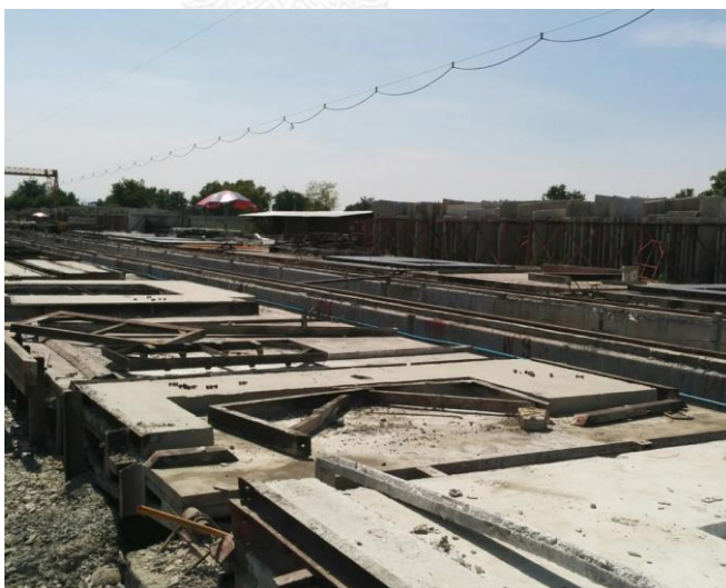
ภาพที่ 9 การผลิตชิ้นส่วนคอนกรีตสำเร็จรูป บริษัท ไลฟ์แอนด์ลีฟวิ่ง จำกัด
