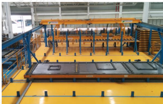
ภาพที่ 72 การติดตั้งเหล็กเสริมโดยเครื่องจักร
