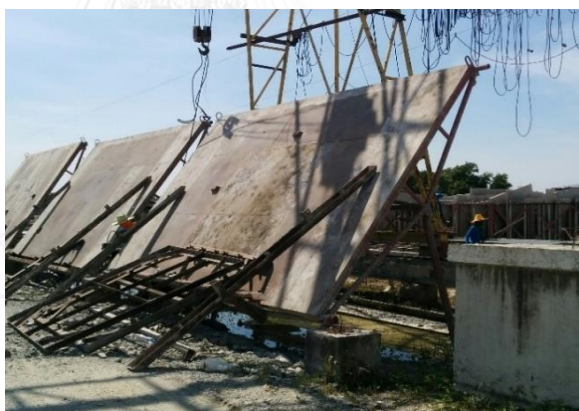
ภาพที่ 37 การทำความสะอาดโต๊ะแบบ
