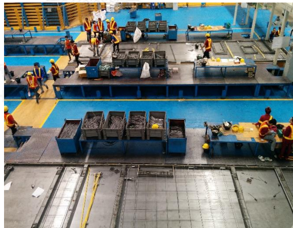
ภาพที่ 75 การติดตั้งงานระบบภายในผนัง
