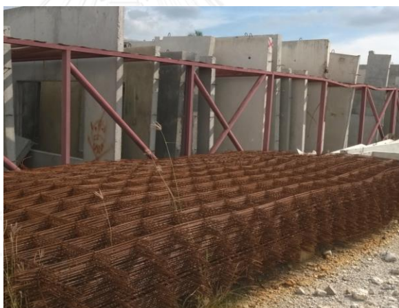
ภาพที่ 35 เหล็กเสริม โครงการแฟมลี ชิตี้ พานทอง
