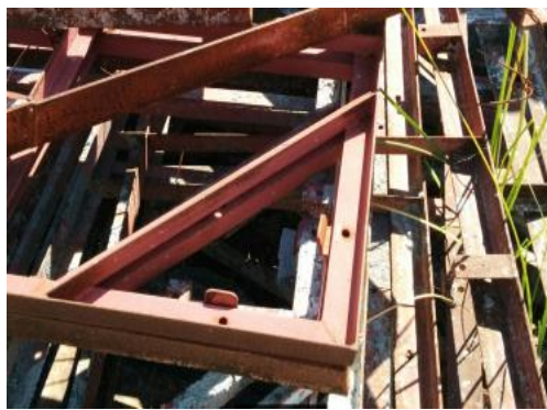
ภาพที่ 105 แบบข้างเหล็ก โครงการพมิลี่ ซิตี้ พานทอง
