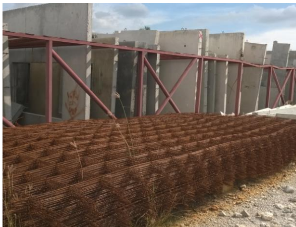
ภาพที่ 43 ตะแกรงเหล็กสำเร็จรูป
