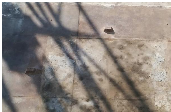
ภาพที่ 39 Block-out บนโต๊ะแบบสำหรับกำหนดตำแหน่งงานระบบไฟฟ้า
