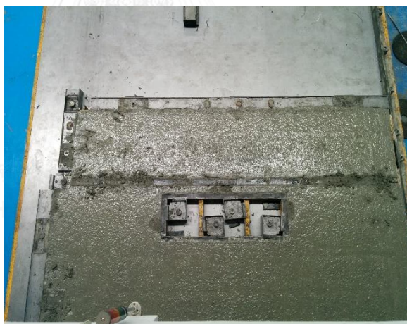
ภาพที่ 77 ชั้นส่วนที่เทคอนกรีตเสร็จเรียบร้อยแล้ว
