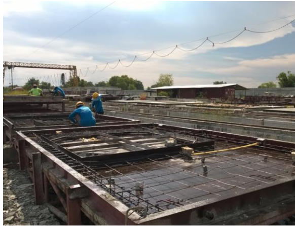
ภาพที่ 45 การติดตั้งอุปกรณ์ภายในผนัง
