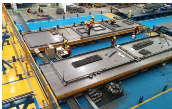
ภาพที่ 70 การติดตั้งไม้แบบ
