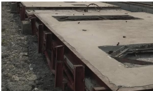
ภาพที่ 50 การบ่มคอนกรีต
