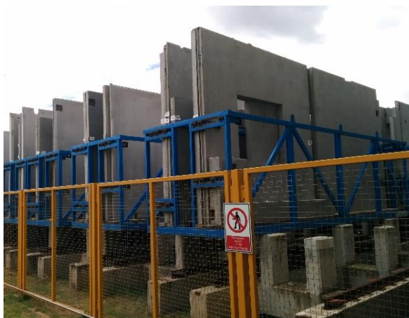
ภาพที่ 88 พื้นที่เก็บชิ้นส่วนเพื่อรอการขนส่ง
