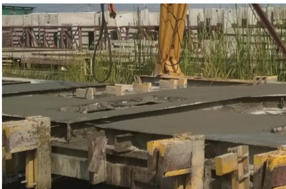
ภาพที่ 47 การเทคอนกรีต
