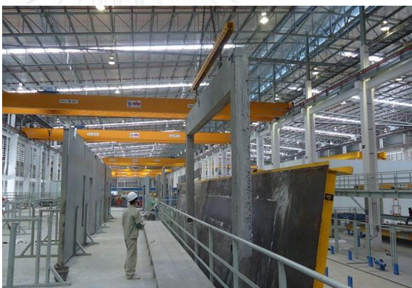
ภาพที่ 86 การยกชิ้นส่วนคอนกรีตสำเร็จรูปไปเก็บในตะกร้า ที่มา บริษัท พุกชา เรยลเอสเตท จำกัด(มหาชน)
