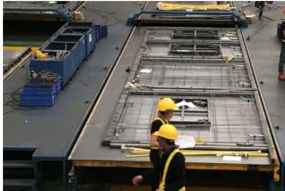
ภาพที่ 73 การติดตั้งเหล็กเสริมโดยแรงงาน
