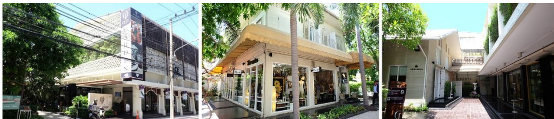
รูปที่ 4-11 ภาพบรรยากาศโครงการ ในส่วนทางเข้าด้านหน้าโครงการ คือ อาคาร E และ D และลานระหว่างอาคาร C กับ E ตามลำดับ
