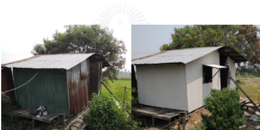
ภาพที่ 5- 3 แสดงกรณีปรับปรุงซ่อมแซมผนังที่ผุพัง
