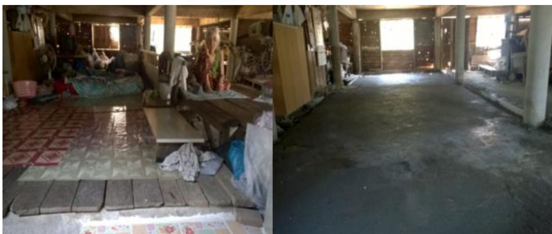
ภาพที่ 5- 1 แสดงกรณีปรับปรุงพื้นบ้านที่ต่างระดับให้เรียบเพื่อง่ายต่อการเคลื่อนไหว
