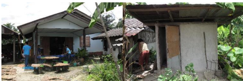
ภาพที่ 5- 5 แสดงกรณีที่มีห้องน้ำอยู่ในบ้านแล้วแต่สร้างเพิ่มอีก
