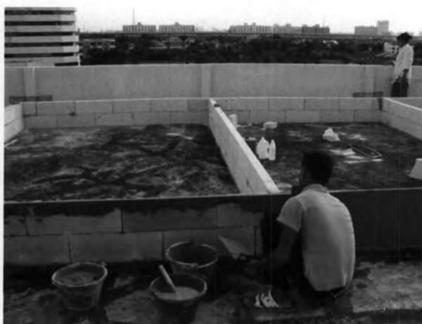
รูปที่ 3.18 แสดงการเตรียมแบ่งพื้นที่การปลูกหญ้าปกคลุมหลังคา ซึ่งอยู่ด้านบนของหลังคา คสล. ดาดฟ้าด้านบนห้องชั้น 6 ของอาคารกรณีศึกษา
