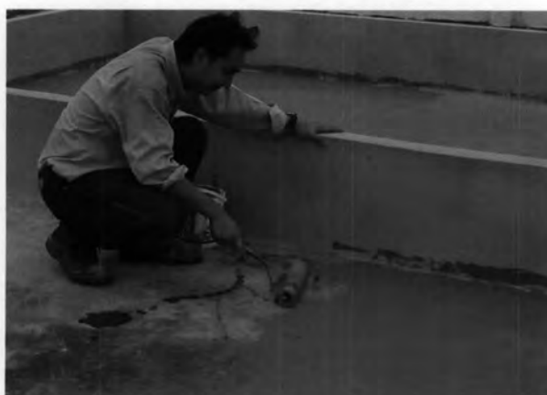
รูปที่ 3.19 แสดงการทำชั้นน้ำยากันซึมของหลังคา คสล. ดาดฟ้าด้านบนห้องชั้น 6 ของอาคารกรณีศึกษา
