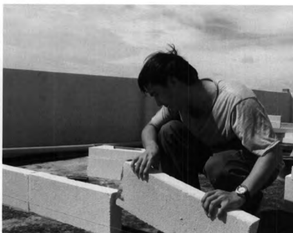
รูปที่ 3.17 แสดงการเตรียมแบ่งพื้นที่การปลูกหญ้าปกคลุมหลังคา ซึ่งอยู่ด้านบนของหลังคา คสล. ดาดฟ้าด้านบนห้องชั้น 6 ของอาคารกรณีศึกษา
