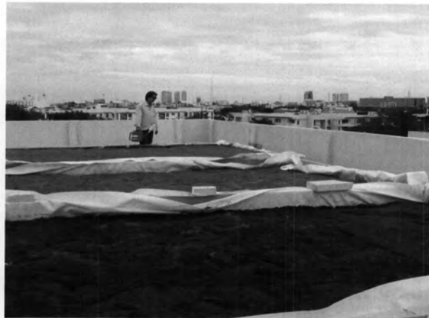
รูปที่ 3.33 แสดงการดำเนินปลูกหญ้าฉนวนน้อยภายในกระบะปลูก กระบะด้านบนห้องกรณีศึกษาที่ 2, 3 และ 4
