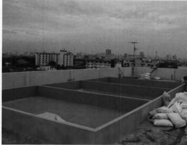
รูปที่ 3.20 แสดงการทำชั้นน้ำยากันซึมของหลังคา คสล. ด้านบนของห้องกรณีศึกษา
