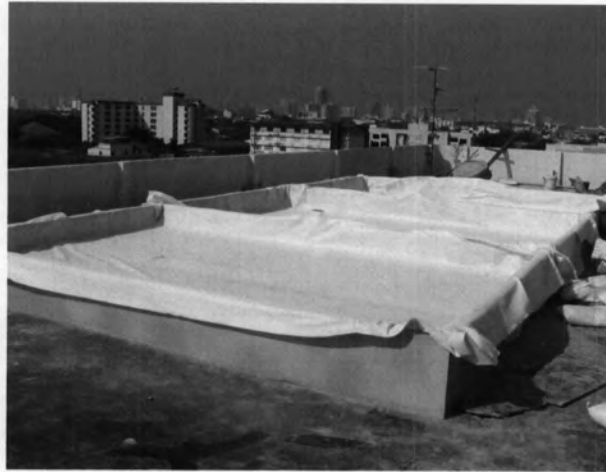
รูปที่ 3.29 แสดงการติดตั้งแผ่นใยกรองดินภายในกระบะปลูกแต่ละกระบะ
