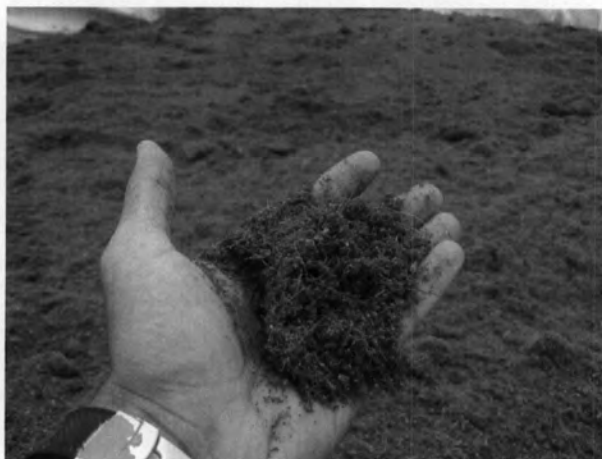
รูปที่ 3.31 แสดงการจัดใส่ขุยมะพร้าวภายในกระบะปลูก กระบะด้านบนห้องกรณีศึกษาที่ 3
