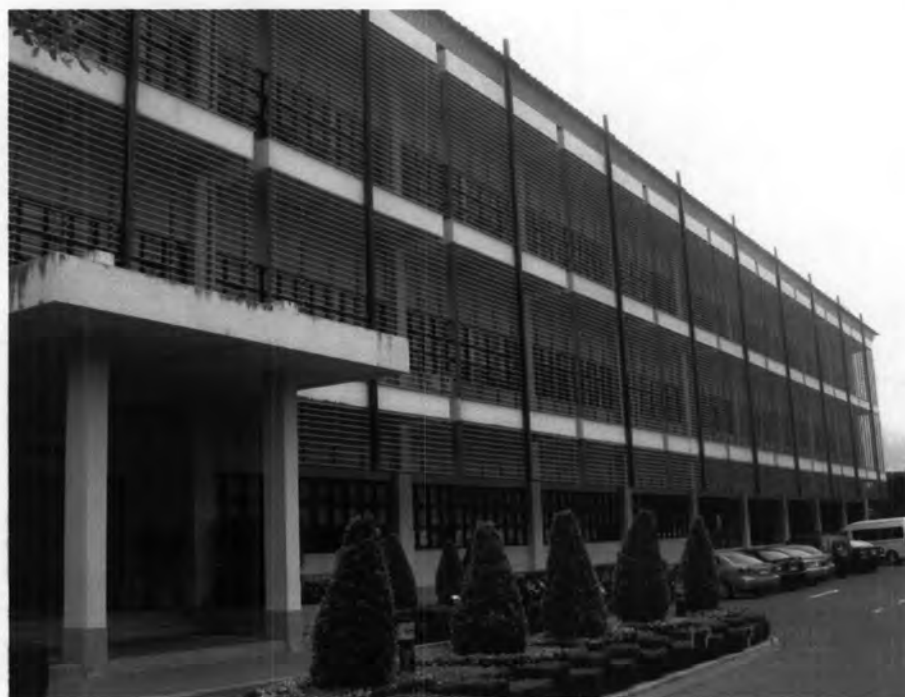
รูปภาพที่ 3.56 อาคารสำนักงานอำนวยการ
