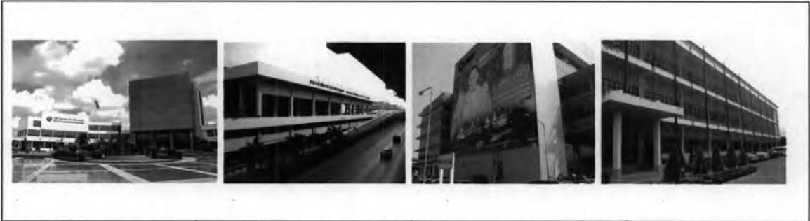
รูปภาพที่ 3.64 อาคารสำนักงานบริษัท ท่าอากาศยานไทย จำกัด มหาชน ในเขตกรุงเทพมหานคร
