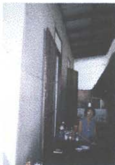
ภาพที่ 5.20 ทางเดินเรือนไม้ที่สร้างใหม่
