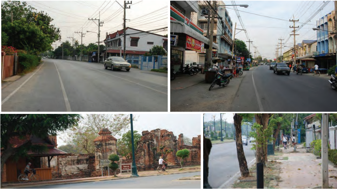
ภาพ 5. 2 ตัวอย่าง เส้นทางจักรยานบริเวณถนนอุททอง ที่มีลักษณะไม่ต่อเนื่องกัน ลักษณะการใช้เส้นทางจักรยานซ้อนทับกับเส้นทางเดินเท้า
