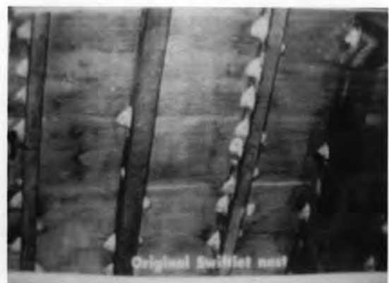
ภาพที่ 4.9 – 4.10 แสดงลักษณะเพดานตีไม้ซอยแบ่งช่อง ภายในอาคารเรือนนก
