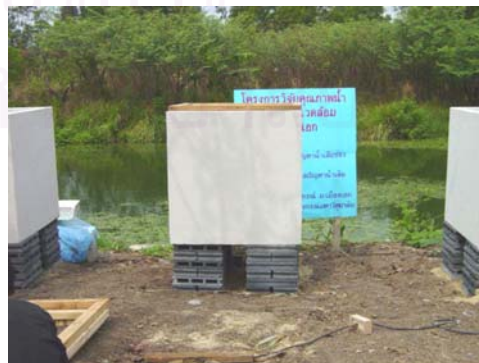
(ข) แสดงโครงไม้ที่เป็นฐานรองรับโครงหลังคาที่ติดตั้งเสร็จแล้ว
