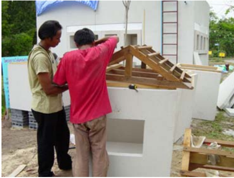
(ค) แสดงการติดตั้งโครงหลังคาไม้ลงบนผนังหุ่นจำลอง
