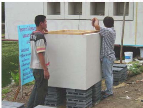
รูป 3-8 (ก) แสดงการติดตั้งโครงไม้ที่เป็นฐานรองรับโครงหลังคา
