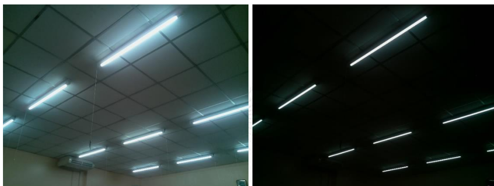
รูปที่ 3-7 เปรียบเทียบภาพถ่ายที่ใช้ความเร็วชัตเตอร์ 1/18 วินาทีกับ 1/160 วินาที
