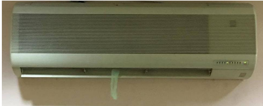
รูปที่ 3-9 เครื่องปรับอากาศที่ติดตั้งอุปกรณ์แสดงสถานะ
