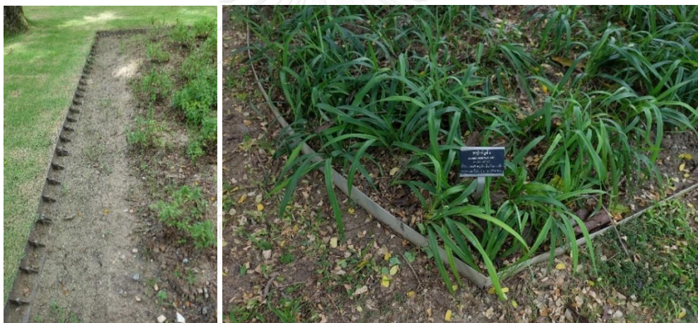
รูปที่ 48 การฝังเหล็กแผ่นเพื่อควบคุมขอบเขต
