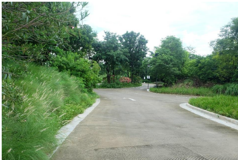
รูปที่ 61 ถนนทางเข้า
