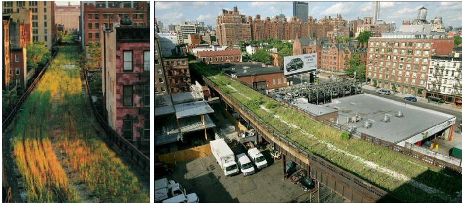
รูปที่ 6 รางรถไฟก่อนปรับปรุง
