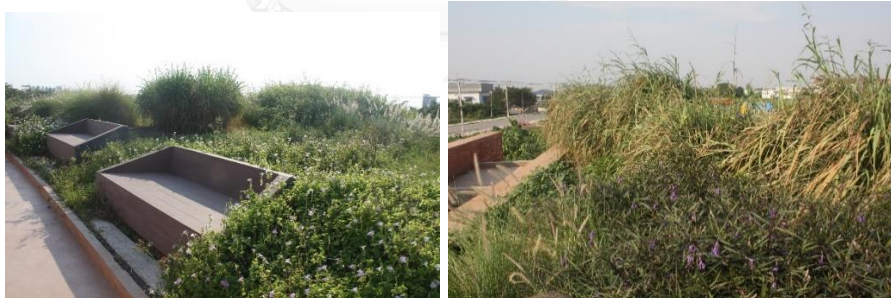
รูปที่ 32 ผลการสำรวจหลังคา A วันที่ 4 กุมภาพันธ์ 2559
