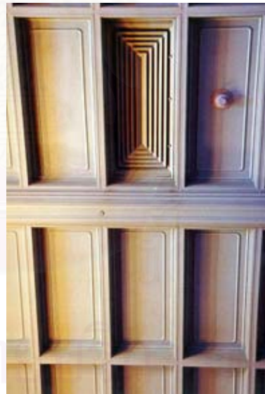
ภาพ3.66 ห้องบนชั้นสองของตำหนัก ใช้หน้ากากจ่ายลมเย็นอยู่ในลวดลายตารางของฝ้าเพดาน
