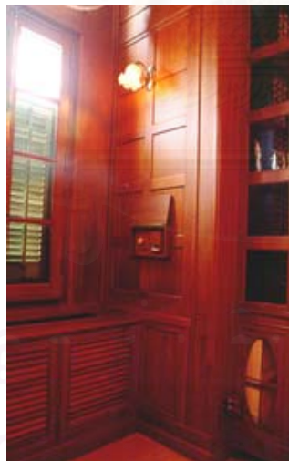
ภาพ 3.64 ตู้เป่าลมเย็นสำหรับห้องต่างๆชั้นล่างของตำหนัก และ ตีกล่องทำเฟอร์นิเจอร์ให้เข้ากับรูปแบบภายใน
