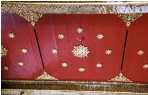
ภาพ 4.18 ช่องจ่ายลมเย็นพระที่นั่งอมรินทรวินิจฉัย ภาพ 4.19 ช่องจ่ายลมเย็น หอประชุมจุฬาลงกรณ์มหาวิทยาลัย หรือในส่วนที่อยู่บนพื้น ก็อาจจะเจาะช่องบนพื้น ใสน้ำกากจ่ายลมเย็นเป่าขึ้นมา แล้วตำแหน่งช่องหน้ากาก็อยู่ชิดกับผนัง อาจจะทำช่องหรือออกแบบลวดลายให้กลืนไปกับลายพื้น หรือมีการตั้งเฟอร์นิเจอร์ บังไว้ (ห้องโปรเวตพระที่นั่งจักรีมหาปราสาท)
