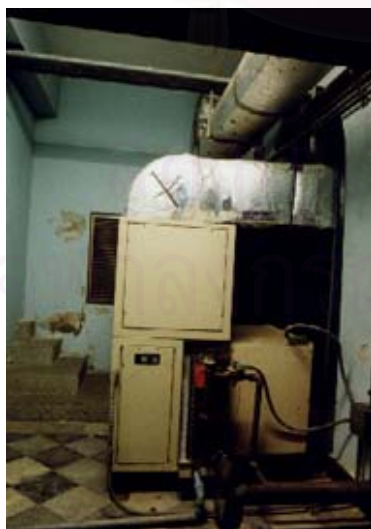
ภาพที่3.14 การเดินท่อส่งลมเย็นจากใต้ถุนพระที่นั่งจักรี ฝ่ายใน ด้านหลัง
