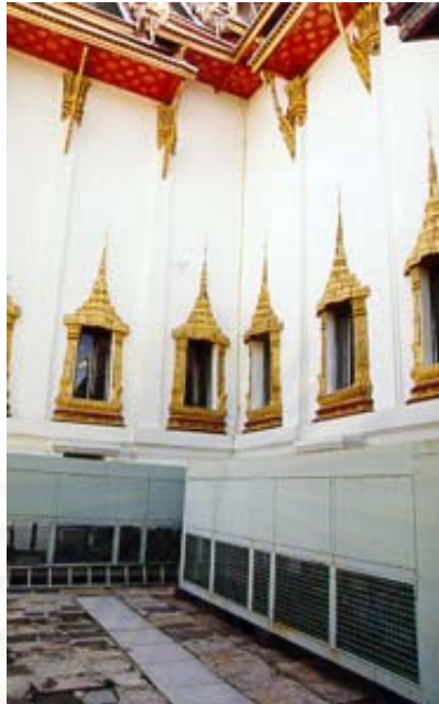
ภาพที่3.19 ตำแหน่งของคอนเดนซิ่งยูนิต
