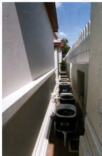
ภาพที่ 3.26-1 คอนเดนซิ่งยูนิตของตำหนักเก็งคู
