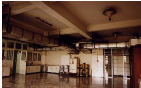
ภาพที่3.13 การเดินท่อส่งลมเย็นจากใต้ถุนพระที่นั่งจักรี ฝ่ายใน ด้านหลัง
