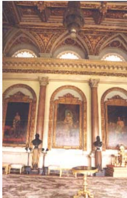
ภาพที่3.14-4 ลมเย็นในส่วนมุขกระสันตะวันออก ออกจากช่องเหนือผนังตรงช่องแสงแต่ละซุ้ม (ทางด้านขวามือ)
