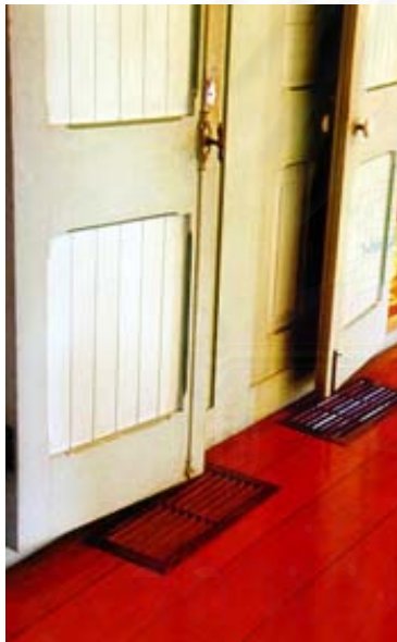
ภาพที่ 3.47 ช่องจ่ายลมเย็น ชั้น 1 เดินท่อลมเย็นจากใต้ถุนเป่าผ่านพื้นขึ้นมา โดยหน้าต่างทำสีเลียนแบบลายไม้
