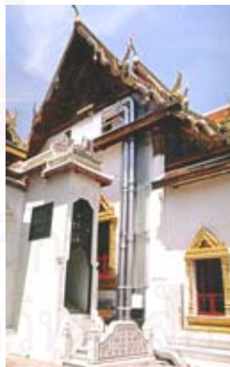
ภาพ 5.1 ตำแหน่งการเดินท่อส่งความเย็นเข้าของพระที่นั่งอมรินทรวินิจฉัยฯ
