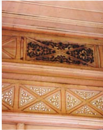
ภาพ 3.54 ช่องจ่ายลมเย็นจากผนังลายฉลุไม้
