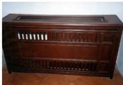
ภาพที่ 3.27 จุดจ่ายลมเย็นเป็นตู้และทำการตกแต่งให้เข้ากับบรรยากาศภายในอาคาร
