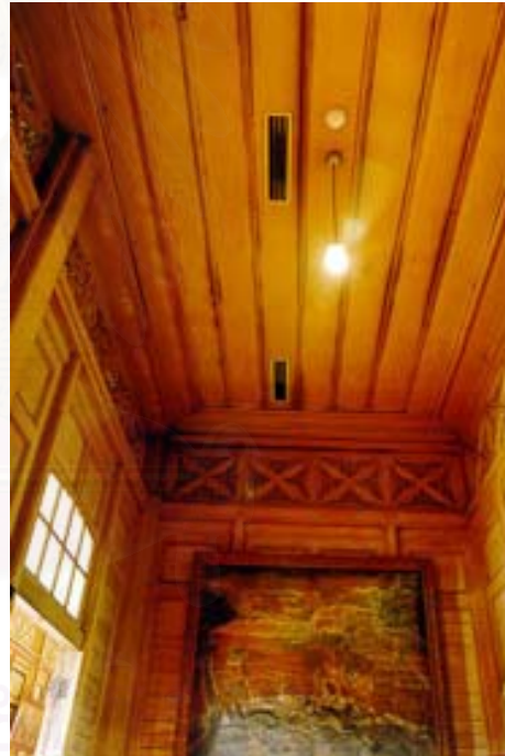
ภาพ 3.49 ช่องจ่ายลมเย็น ของชั้นสอง ส่วนที่เดินทอลมเหนือฝ้าเพดานได้ เป่าลมเย็นลงจากฝ้าเพดานไม้
