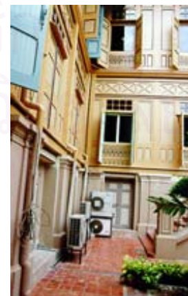
ภาพ4.10 ตำแหน่งคอนเดนซิ่งยูนิตของพระที่นั่งวิมานเมฆจุดที่เสริมขึ้นมาสำหรับส่วนทำงานด้านล่างใต้ถุนพระที่นั่ง
