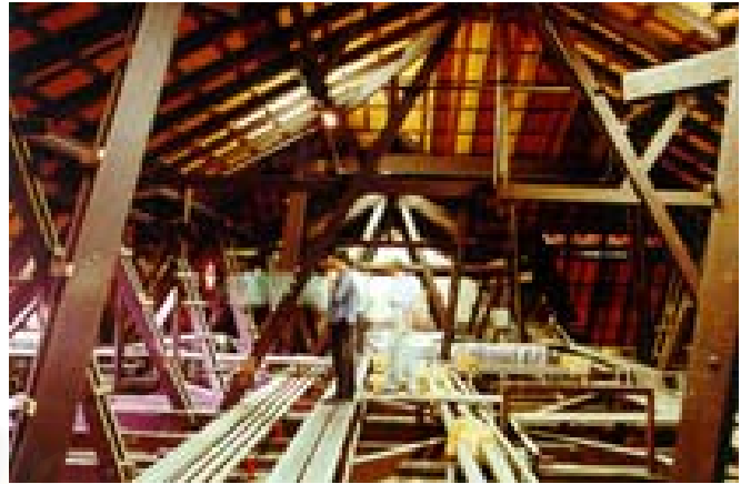
ภาพ 3.71 ในห้องใต้หลังคา มีทางเดินสำหรับให้เข้าไปซ่อมบำรุงได้โดยสะดวก
