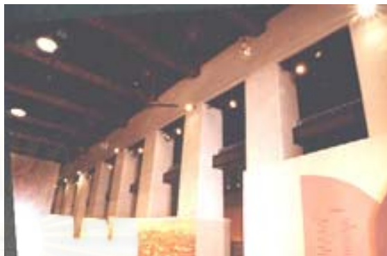
ภาพ 4.23 ส่วนจ่ายลมเย็นของพระที่นั่งอิศราวินิจฉัย ให้เป่าออกจากด้านข้างของพระที่นั่ง โดยทำฝ้าเพดานสำหรับส่วนนิทรรศการและวางแฟนคอยล์แขวนไว้ข้างบน
