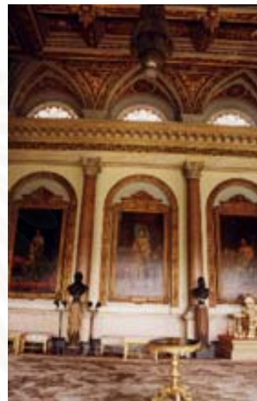
ภาพ 5.9 ช่องจ่ายลมเย็นของพระที่นั่งจักรีมหาปราสาท ส่วน मुखกระสัน ตะวันออกและตะวันตก ซ่อนไว้หลังยอดผนังได้ซุ่ม ช่องแสงแต่ละซุ่ม
