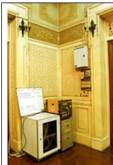
ภาพ 6.45 บริเวณโถงตรงมุมห้องท้าวพระโรงกลางชั้นล่าง เดิมมี สวิตซ์ และส่วนควบคุมไฟอยู่
