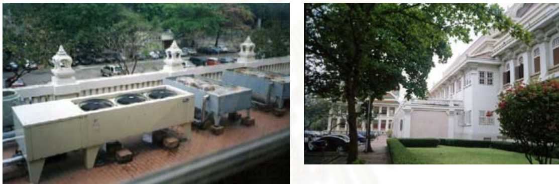
ภาพ 3.74 ตำแหน่งที่ตั้งคอนเดนซึ่งยูนิตสำหรับระบบแยกส่วนที่ใช้
