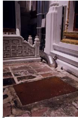
ภาพที่3.6 ด้านข้างของพระที่นั่งอมรินทรวินิจฉัยฯ เดินท่อน้ำเย็นเข้าสู่ภายในอาคาร
