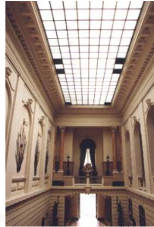
ภาพที่3.14-6 หน้ากากจ่ายลมเย็นโถงหลังพระที่นั่งมุลสถานบรมมหาราชวัง
