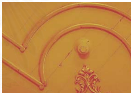
ภาพ 5.3 รอยหยดน้ำบริเวณฝ้าเพดานจากใต้หลังคา
