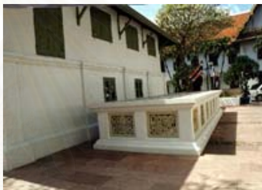
ภาพ 5.8 การทำลวดลายครอบคอนเดนซึ่งยูนิต ของตึกหน้าแกงพระปิ่นเกล้าเพื่อ ให้กลมกลืนกับอาคาร
