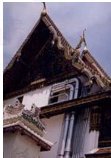
ภาพที่3.5 ด้านข้างของพระที่นั่งอมรินทรวินิจฉัยฯ เดินท่อน้ำเย็นเข้าสู่ภายในอาคาร
