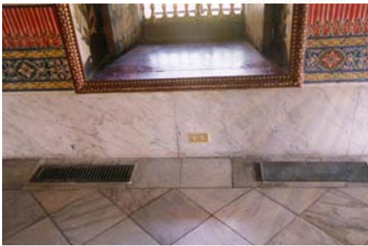
ภาพที่ 3.22 หน้ากากจ่ายลมเย็นของพระที่นั่งดุสิตมหาปราสาท
