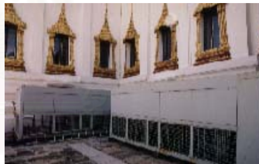
ภาพ 4.12 ตำแหน่งคอนเดนซิ่งยูนิตของพระที่นั่งดุสิตมหาปราสาท เมื่อวางลงไปจะมองไม่เห็นฐานบัวขององค์พระที่นั่ง
