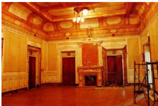
ภาพ 6.43 ห้องพระโรงกลางชั้นสอง อยู่ในระหว่างปรับปรุง ที่มา:ผู้ศึกษาและมนตรีทวี จิรวัดมนตรี ถ่ายเมื่อ 9 สิงหาคม 2543
