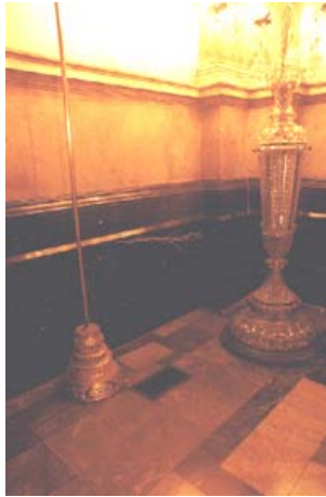
ภาพที่3.14-5 หน้ากากจ่ายลมเย็นจากท้องพระโรง
