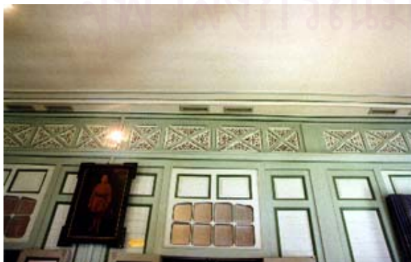
ภาพ 3.49 ช่องจ่ายลมเย็น ของชั้นสอง ส่วนที่เดินทอลมเหนือฝ้าเพดานได้ เป่าลมเย็นลงจากฝ้าเพดานไม้
