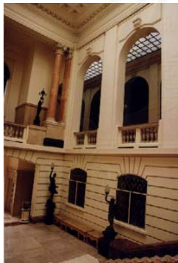
ภาพที่ 3.17 ช่องรับลมกลับ ใช้หน้าต่างของโถงรับลมกลับเข้าสู่ส่วนแฟนคอยล์
