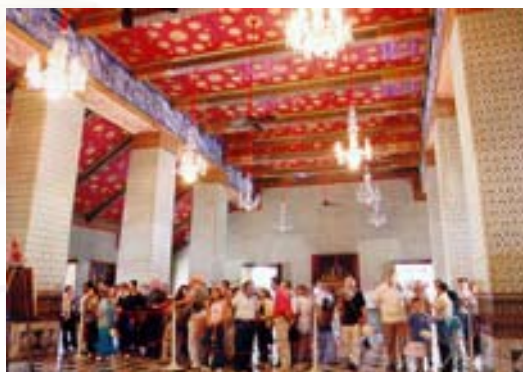
ภาพ 5.12 ช่องจ่ายลมเย็นของพระที่นั่งอมรินทรวินิจฉัยฯ เป็นช่องเล็กๆ ยาวๆ เมื่อมองจากระดับพื้นด้านล่าง จะสังเกตเห็นไม่ค่อยเห็น
