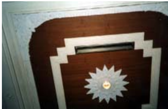
ภาพ 4.18 ช่องจ่ายลมเย็นพระที่นั่งอมรินทรวินิจฉัย ภาพ 4.19 ช่องจ่ายลมเย็น หอประชุมจุฬาลงกรณ์มหาวิทยาลัย หรือในส่วนที่อยู่บนพื้น ก็อาจจะเจาะช่องบนพื้น ใสน้ำกากจ่ายลมเย็นเป่าขึ้นมา แล้วตำแหน่งช่องหน้ากาก็อยู่ชิดกับผนัง อาจจะทำช่องหรือออกแบบลวดลายให้กลืนไปกับลายพื้น หรือมีการตั้งเฟอร์นิเจอร์ บังไว้ (ห้องโปรเวตพระที่นั่งจักรีมหาปราสาท)
