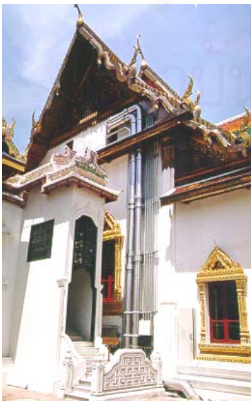
ภาพที่3.5 ด้านข้างของพระที่นั่งอมรินทรวินิจฉัยฯ เดินท่อน้ำเย็นเข้าสู่ภายในอาคาร
