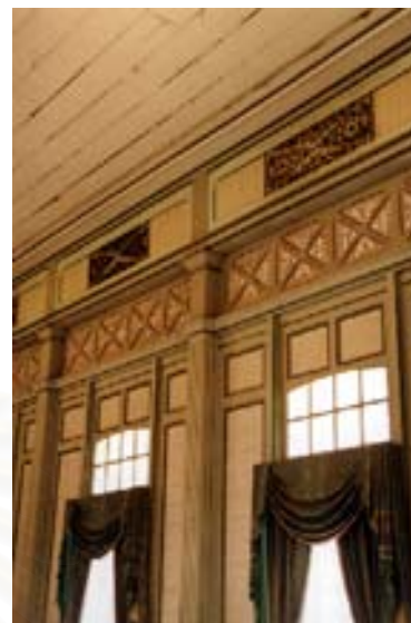
ภาพ 5.11 ช่องจ่ายลมเย็นของพระที่นั่งวิมานเมฆ ชั้นสาม ออกจากผนังที่ทำเลียนแบบลวดลายฉลุ ของผนัง
