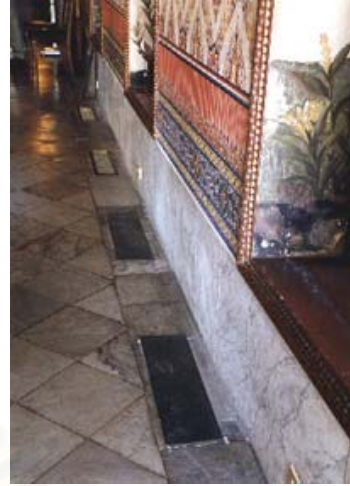
ภาพที่ 3.22 หน้ากากจ่ายลมเย็นของพระที่นั่งดุสิตมหาปราสาท
