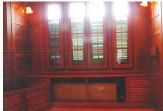
ภาพ 3.64 ตู้เป่าลมเย็นสำหรับห้องต่างๆชั้นล่างของตำหนัก และ ตีกล่องทำเฟอร์นิเจอร์ให้เข้ากับรูปแบบภายใน
