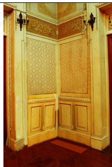
ภาพ 6.451 จำลองการกระจายลม หน้ากากถ่ายลงเขียนชั้น 1 โดยเดินท่อส่งลมเย็นจากใต้ถุน ที่มา: วีระเทพ กิจศิริวิโรจน์ ช่วยแต่งภาพเมื่อ 12 กุมภาพันธ์ 2544
