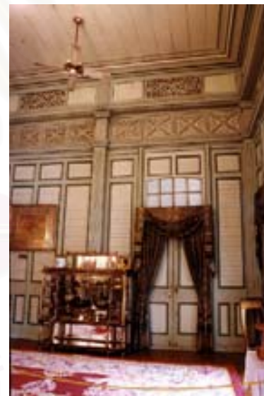
ภาพ 4.17 ชั้นสามพระที่นั่งวิมานเมฆ ให้ลมเย็นเป่า ออกจากบริเวณยอดผนัง ซึ่งทำลายฉลุไม่เลียนแบบ ลวดลายฉลุไม้ตรงผนังข้างล่าง
