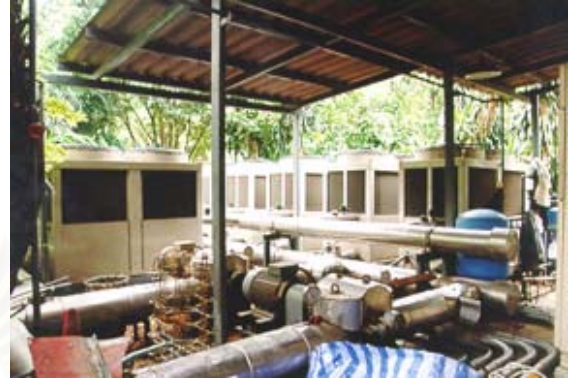
ภาพที่ 3.43 ตำแหน่งคอนเดนซิ่งยูนิต ชุดหลักที่ใช้ ระบบVRV ของ Daikin ลากท่อน้ำยามาไกลจากตัวพระที่นั่ง
