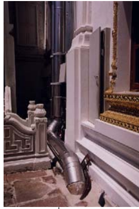
ภาพที่3.6 ด้านข้างของพระที่นั่งอมรินทรวินิจฉัยฯ เดินท่อน้ำเย็นเข้าสู่ภายในอาคาร
