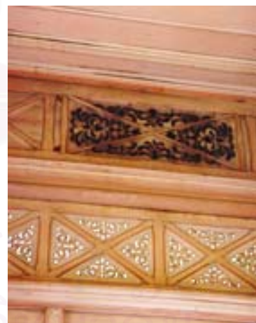
ภาพ 4.28 รอยคราบดำบริเวณช่องลมเย็นชั้นสามที่ เป่าออกจากผนังไม้ ของพระที่นั่งวิมานเมฆ
