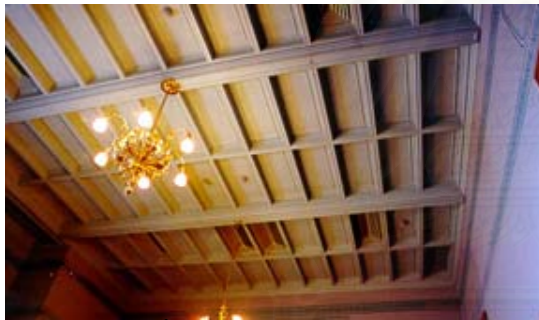
ภาพ3.66 ห้องบนชั้นสองของตำหนัก ใช้หน้ากากจ่ายลมเย็นอยู่ในลวดลายตารางของฝ้าเพดาน
