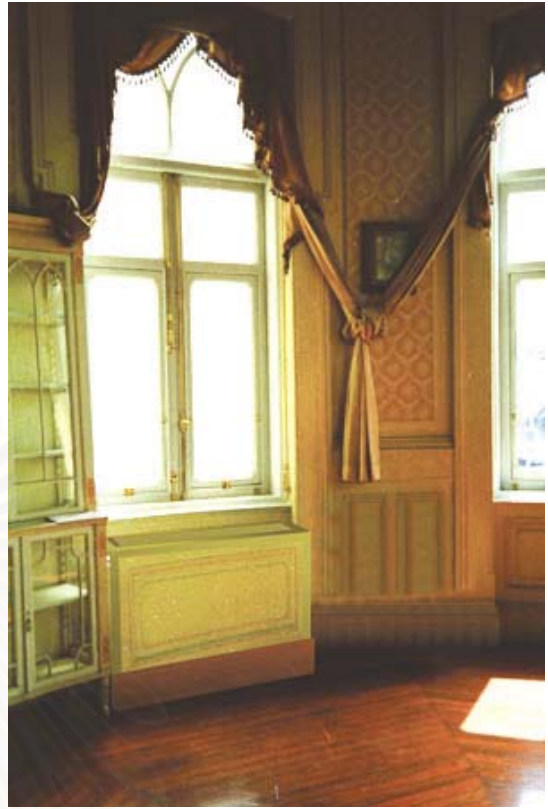
ภาพ 6.501 จำลองส่วนกระจายลมเย็น ตู้แฟนคอยล์ ที่มา: วีระเทพ กิจศิริวิโรฒน์ ช่วยแต่งภาพเมื่อ 12 กุมภาพันธ์ 2544
