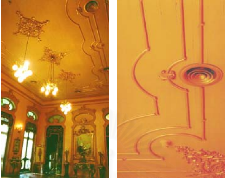
ภาพ3.65 ห้องบนชั้นสองของตำหนัก ใช้หน้ากากจ่ายลมเย็นเป็นส่วนหนึ่งของลวดลาย
