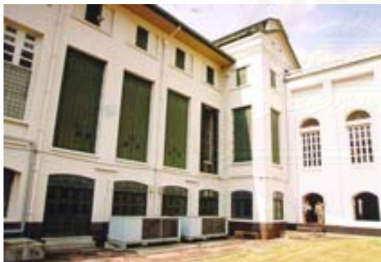
ภาพ 4.2 ตำแหน่งคอนเดนซิ่งยูนิตของพระที่นั่งจักรีมหาปราสาท อยู่บริเวณด้านหลัง
