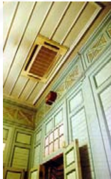
ภาพ 3.50 ช่องจ่ายลมเย็น ของชั้นสอง ส่วนที่เดินท้อลมเหนือฝ้าเพดานได้ เปาลมเย็นลงจากฝ้าเพดานไม้ รูปแบบของหน้ากาช่องจ่ายลมเย็น ในบางห้องมีการลองใช้Fan coil ของ Daikin แบบที่แนบติดกับฝ้าเพดาน
