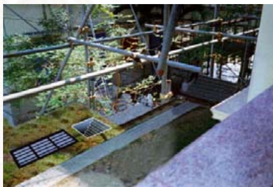
ภาพ 6.391ภาพจำลองบริเวณวางคอนเดนซึ่งยูนิต โดยขุดลงไปใต้ดิน ที่มา: วีระเทพ กิจศรีวิโรฒน์ ช่วยแต่งภาพเมื่อ 12 กุมภาพันธ์ 2544
