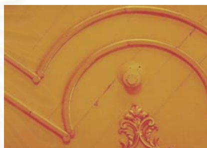
ภาพ 4.27 รอยหยดน้ำบริเวณฝ้าเพดานจากใต้หลังคา
