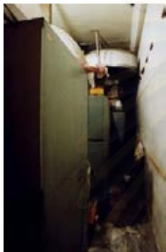
ภาพที่3.13 การเดินท่อส่งลมเย็นจากใต้ถุนพระที่นั่งจักรี ฝ่ายใน ด้านหลัง
