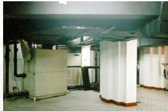
ภาพที่ 3.42 คอนเดนซิ่งยูนิตชุดแรก บริเวณใต้ถุนพระที่นั่ง
