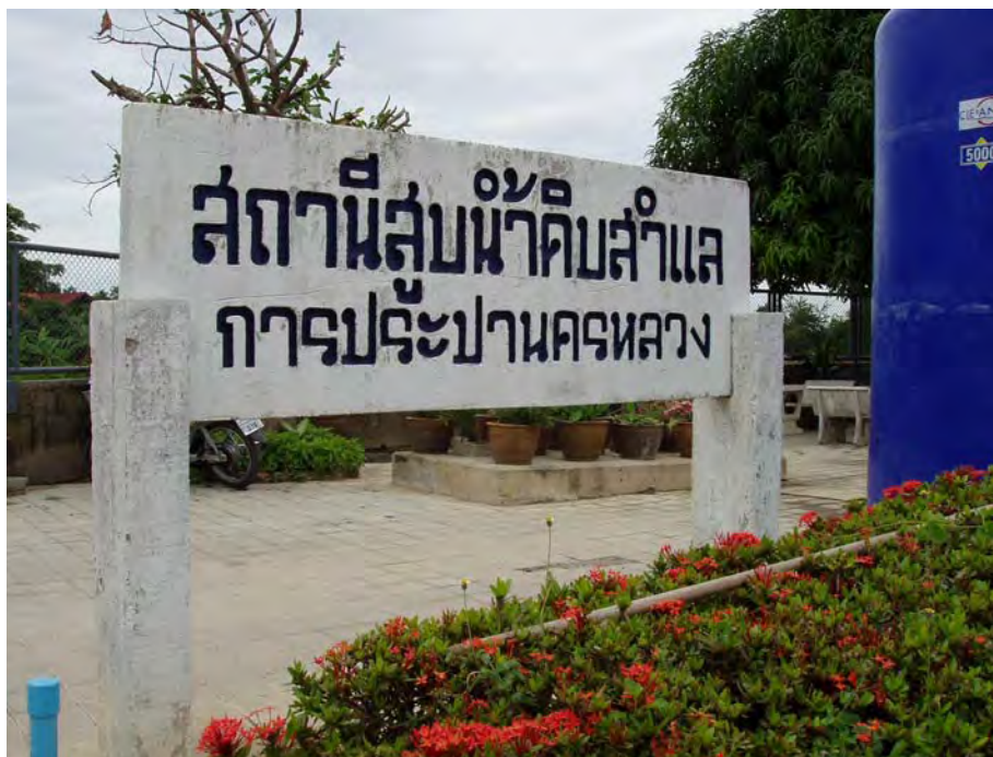
รูปที่ 3.8 สถานีสูบน้ำดิบสำแล
