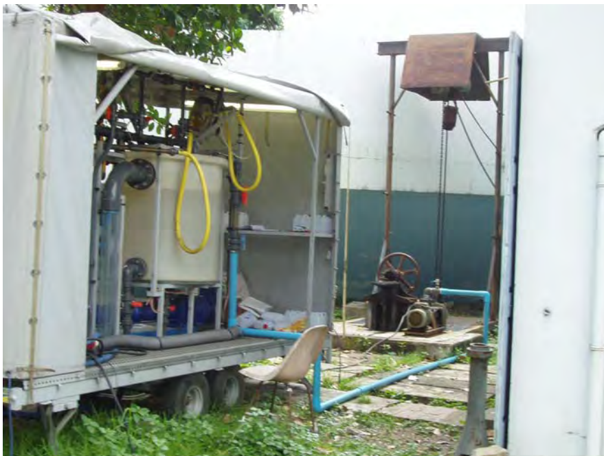
รูปที่ 3.12 ที่ตั้งโรงงานนำร่อง (Pilot Plant) ภายในโรงกรองน้ำสามเสน 2
