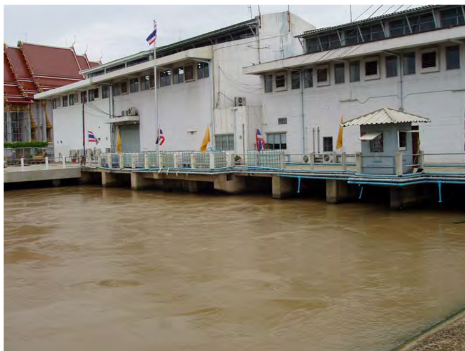
รูปที่ 3.9 จุดที่น้ำดิบผ่านจากสถานีสูบน้ำเพื่อส่งผ่านไปทางคลองประปา
