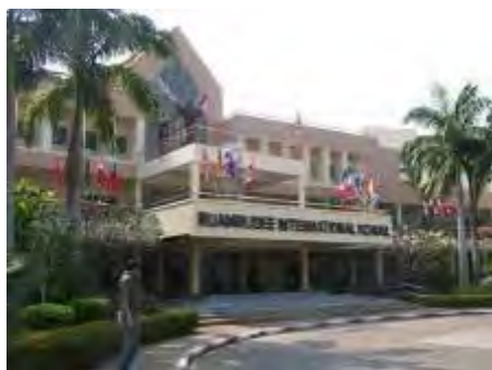
ภาพที่ 3.70 อาคารสำนักงาน
