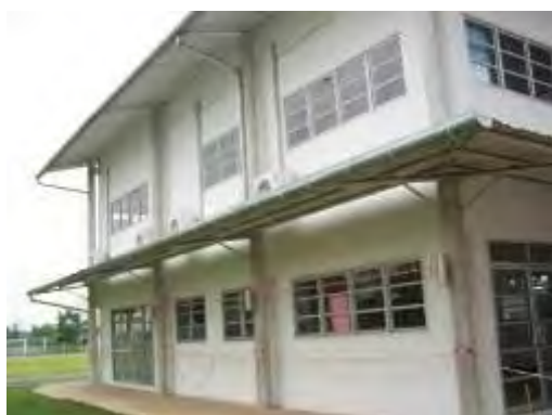
ภาพที่ 3.38 อาคารเรียนและ ฝ้ายช่างซ่อมบำรุง
