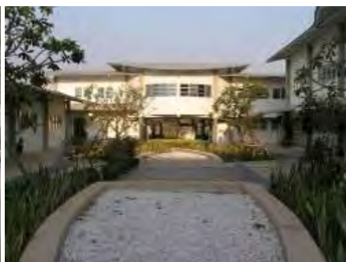
ภาพที่ 3.37 อาคารสำนักงาน
