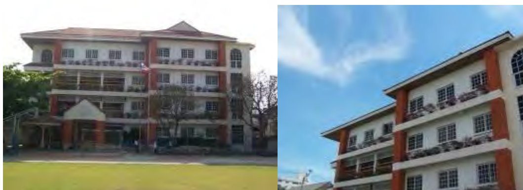
ภาพที่ 3.19 ด้านหน้าอาคารเรียนหลังเก่า (ประถมและอนุบาล)
