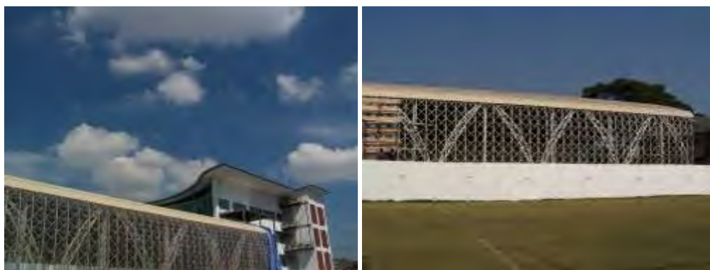
ภาพที่ 3.22 อาคารโรงยิม โครงเหล็กและเกร็ดระบายอากาศ
