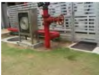
ภาพที่ 3.44 จุดเชื่อมต่อสำหรับรถดับเพลิง ( Fire department connection) และตู้ดับเพลิง
