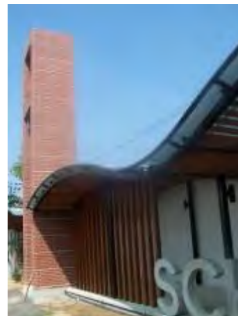
ภาพที่ 3.25 ทางเดินเชื่อมอาคารและหอนาฬิกา
