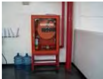
ภาพที่ 3.44 จุดเชื่อมต่อสำหรับรถดับเพลิง ( Fire department connection) และตู้ดับเพลิง
