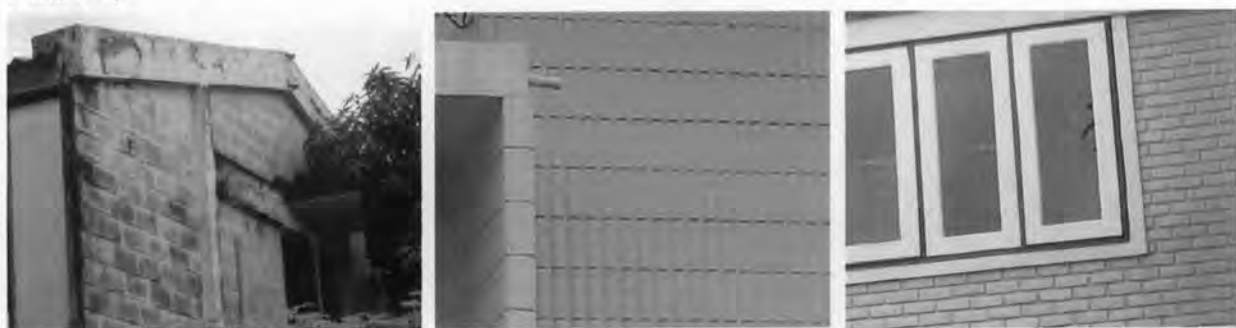
ภาพที่ 7.3 วัสดุก่อผนัง (คอนกรีตบล็อก คอนกรีตบล็อกฉาบ และอิฐมอญ ตามลำดับ)
