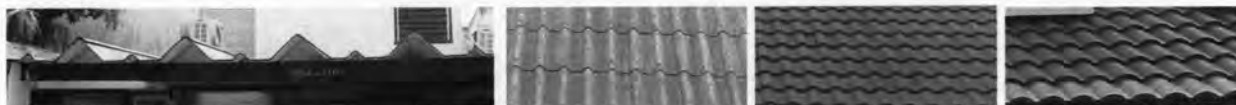
ภาพที่ 7.2 วัสดุผนังหลังคา (หลังคากระเบื้องลอนใหญ่ กระเบื้องลูกฟูก กระเบื้องคอนกรีต กระเบื้องคอนกรีตรุ่นใหม่ ตามลำดับ)
