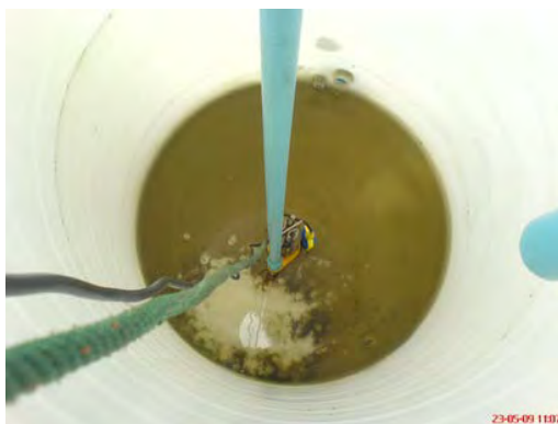
รูปที่ 3.6 เครื่องสูบน้ำเสียเข้าถัง
