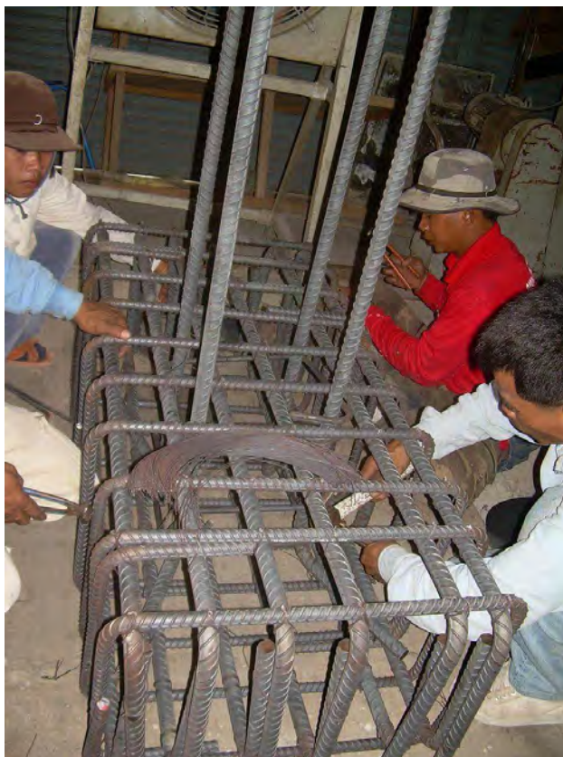
รูปที่ 4.8 การประกอบของเหล็กเสริมตามยาวและฐานรากเข้าด้วยกัน
