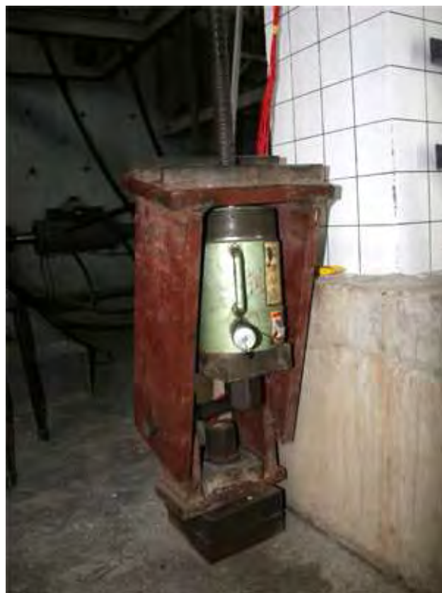
รูปที่ 4.21 การติดตั้งเครื่องให้แรงแบบใช้มือควบคุม
