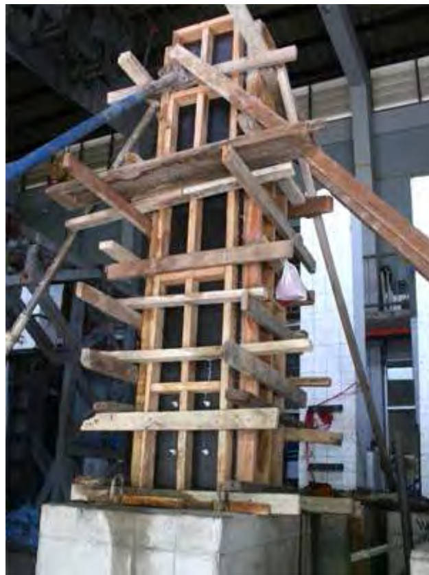
รูปที่ 4.12 การยึดตั้งแบบหล่อตัวอย่างเสา
