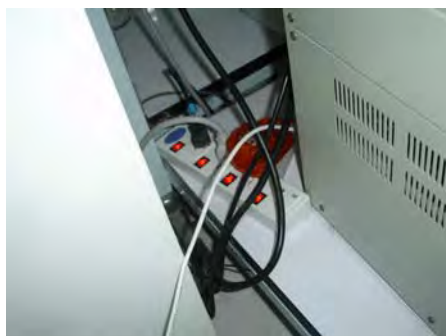
รูปที่ 6-29 บริเวณที่มีการใช้ปลั๊กพ่วงต่อกับ เครื่องวิเคราะห์อัตโนมัติ
