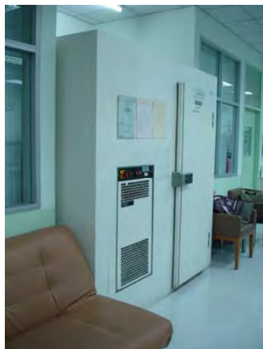
รูปที่ 4-17 ห้องเย็น
