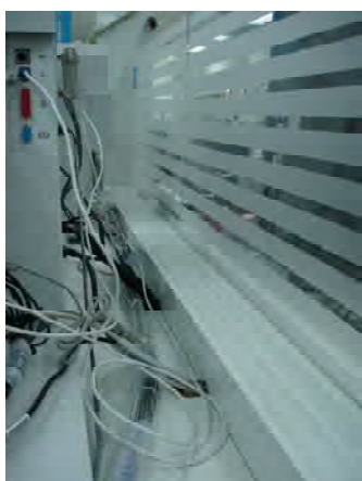
รูปที่ 5-46 ช่องเดินสายไฟหลังเครื่องวิเคราะห์
