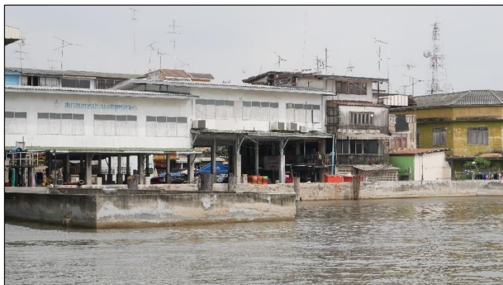
รูปที่ 22 แสดงภาพสะพานปลาของเทศบาล
