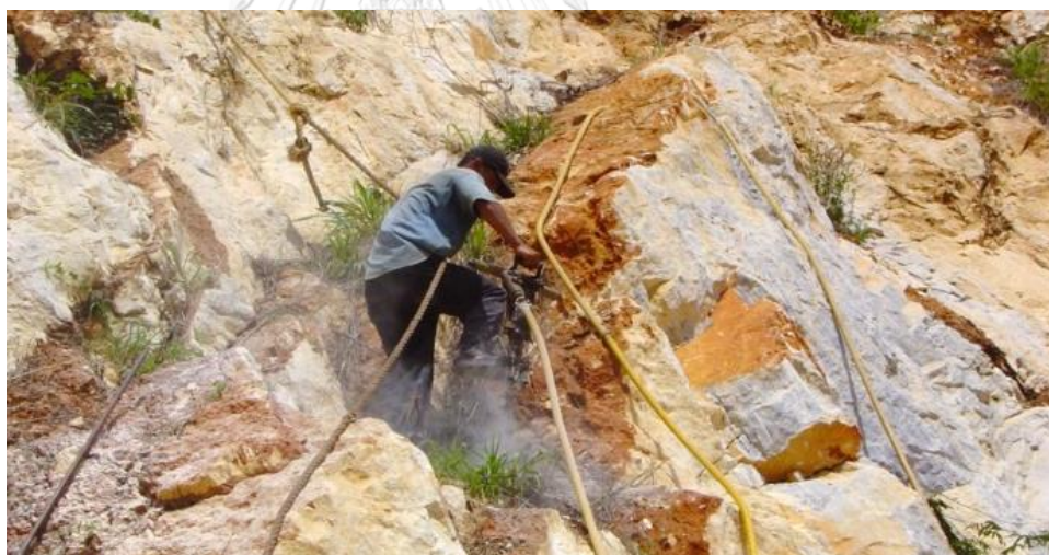
รูปภาพที่ 54 การปรับปรุงเสถียรภาพเชิงลาดบนพื้นที่ที่มีความชันมากกว่า 100% ด้วยเทคนิคการโรยตัวเพื่อเจาะและกระแทกหินในพื้นที่ขนาดเล็ก เพื่อให้การฟื้นฟูเกิดพืชพรรณที่ปกคลุมที่มาก กลุ่มฟื้นฟูคุณภาพสิ่งแวดล้อม กรมอุตสาหกรรมพื้นฐานและการเหมืองแร่, 2560
