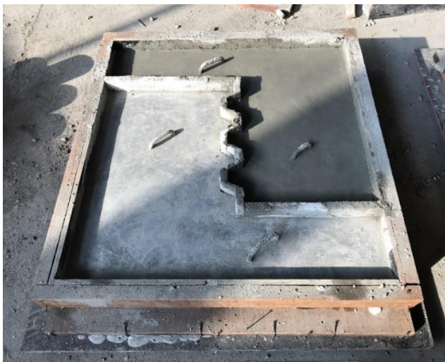
รูปที่ 3. 16 เทคอนกรีตในแบบหล่อครั้งที่ 2
