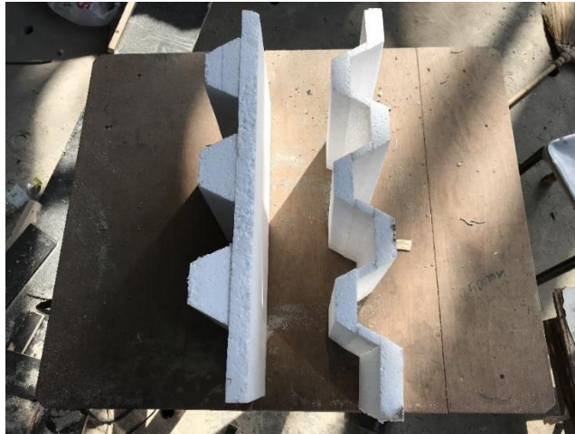
รูปที่ 3. 13 แผ่นเหล็กและโฟมกันคอนกรีตเป็นรูปสลักรับแรงเฉือน
