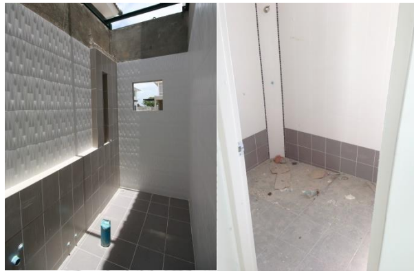
ภาพที่ 57 งานปูกระเบื้องห้องน้ำ
