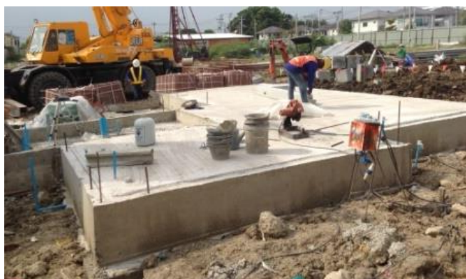
ภาพที่ 97 งานพื้นคอนกรีตหล่อในที่ บริษัท พกษา โฮลดิ้ง จำกัด (มหาชน)
