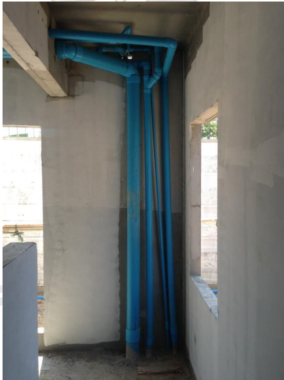
ภาพที่ 38 การเดินท่องานระบบใต้พื้นห้องน้ำ ชั้นบน บริษัท พกษา โฮลดิ้ง จำกัด (มหาชน)
