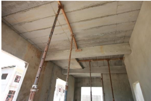
ภาพที่ 87 งานที่ 2 ติดตั้งคานและพื้น ชั้นบน บริษัท โลฟ แอนด์ สีฟวี่ จำกัด
