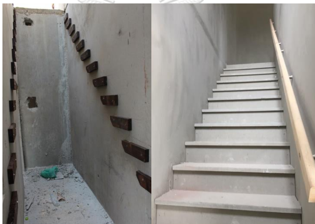
ภาพที่ 47 งานติดตั้งบันได
