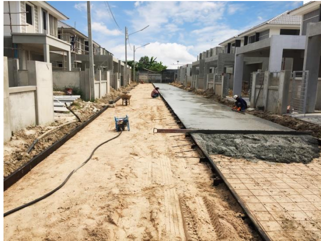
ภาพที่ 72 งานเทพื้นคอนกรีตหน้าบ้าน บริษัท โลฟ แอนด์ สีฟวี่ จำกัด
