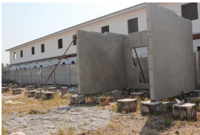
ภาพที่ 29 การติดตั้งผนังคอนกรีตสำเร็จรูป ชั้นล่าง บริษัท โลฟ แอนด์ ลีฟวิ่ง จำกัด
