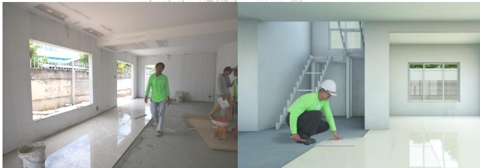
ภาพที่ 58 งานปูกระเบื้องภายในชั้นล่าง
