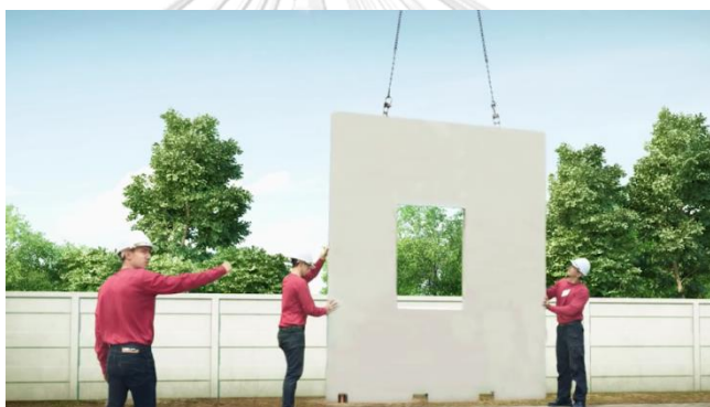
ภาพที่ 79 จำลองงานติดตั้งผนังคอนกรีตสำเร็จรูป ชั้นล่าง บริษัท พุกษา โฮลดิ้ง จำกัด (มหาชน)
