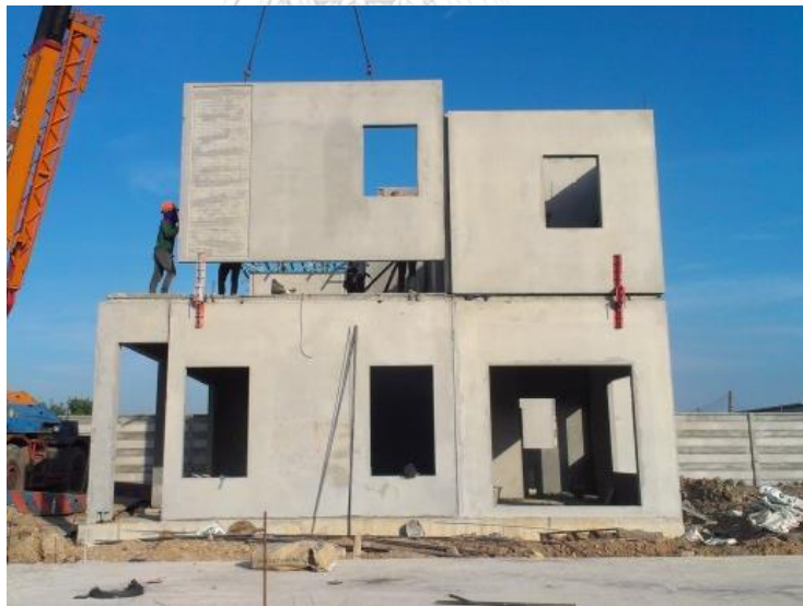
ภาพที่ 93 งานที่ 3 ติดตั้งผนังชั้นบน บริษัท พกษา โฮลดิ้ง จำกัด (มหาชน)
