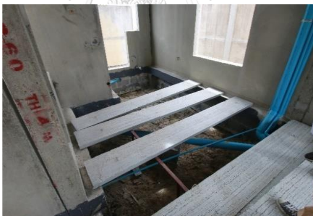
ภาพที่ 28 การติดตั้งแผ่นพื้นคอนกรีตสำเร็จรูป บริษัท โลฟ แอนด์ ลีฟวิ่ง จำกัด
