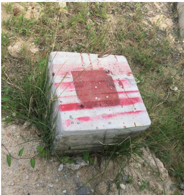
ภาพที่ 22 ฐานตอม่อที่ติดแผ่นเหล็กบนหัวเสาเข็ม บริษัท โลฟ แอนด์ ลีฟวิ่ง จำกัด
