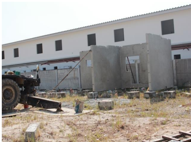
ภาพที่ 74 งานติดตั้งผนังคอนกรีตสำเร็จรูป ชั้นล่าง บริษัท โลฟ แอนด์ ลีฟวิ่ง จำกัด
