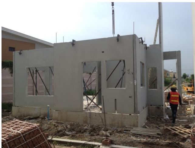
ภาพที่ 78 งานติดตั้งชิ้นส่วนผนังคอนกรีตสำเร็จรูป ชั้นล่าง บริษัท พุกษา โฮลดิ้ง จำกัด (มหาชน)
