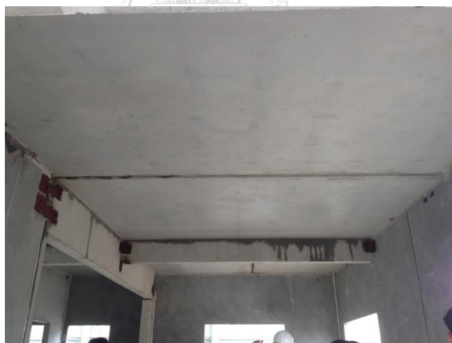
ภาพที่ 32 การติดตั้งชิ้นส่วนคาน และพื้นคอนกรีตสำเร็จรูป ชั้นบน บริษัท พกษา โฮลดิ้ง จำกัด (มหาชน)
