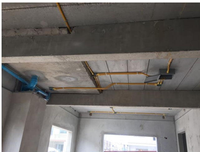
ภาพที่ 51 งานเดินท่อร้อยสายไฟฟ้า บริษัท โลฟ แอนด์ สีฟวิ้ง จำกัด
