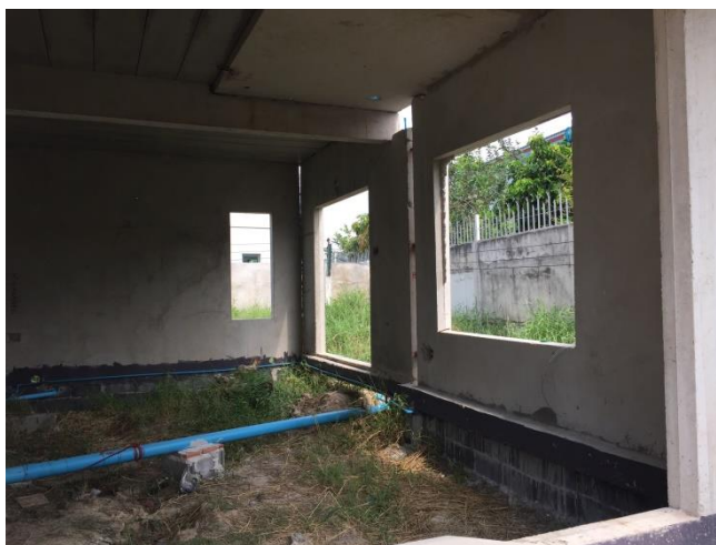
ภาพที่ 80 หุ้มข้างบริเวณใต้ฐานผนังชั้นล่าง บริษัท โลฟ แอนด์ ลีฟวิ่ง จำกัด
