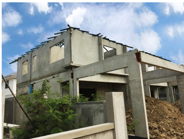
ภาพที่ 41 งานโครงหลังคาเหล็กรูปพรรณ บริษัท โลฟ แอนด์ ลีฟวิ่ง จำกัด
