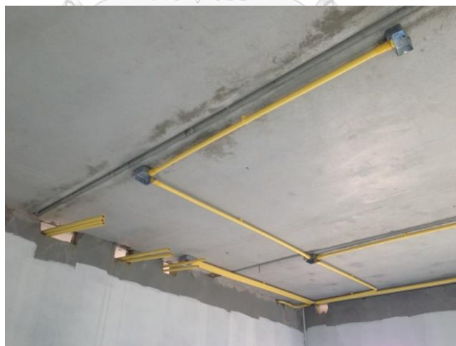
ภาพที่ 52 งานเดินท่อร้อยสายไฟฟ้า บริษัท พกษา โฮลดิ้ง จำกัด (มหาชน)
