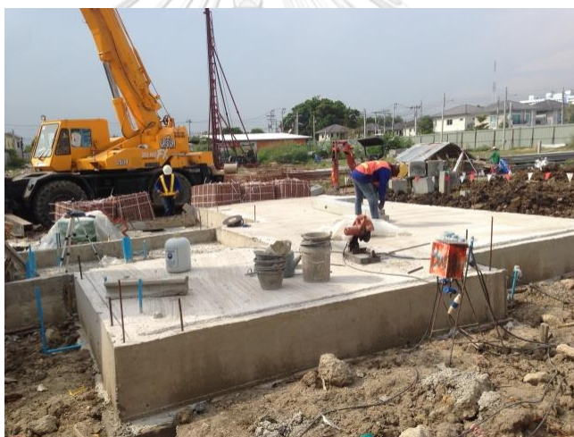
ภาพที่ 77 พื้นคอนกรีตหล่อทับที่ ชั้นล่าง บริษัท พกษา โฮลดิ้ง จำกัด (มหาชน)
