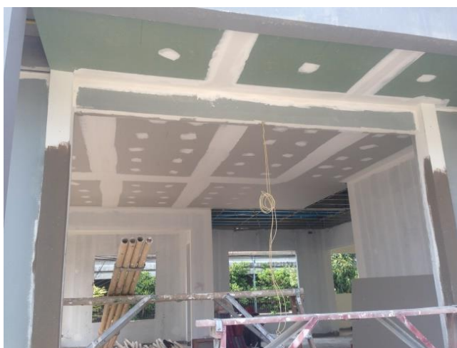
ภาพที่ 53 งานติดตั้งฝ้าเพดานภายใน บริษัท โลฟ แอนด์ สีฟวิ่ง จำกัด
