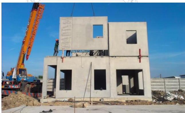
ภาพที่ 34 การติดตั้งผนังคอนกรีตสำเร็จรูป ชั้นบน บริษัท พกฤษา โฮลดิ้ง จำกัด (มหาชน)
