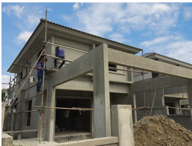
ภาพที่ 55 งานตกแต่งเปลือกอาคาร บริษัท โลฟ แอนด์ สีฟวี่ จำกัด
