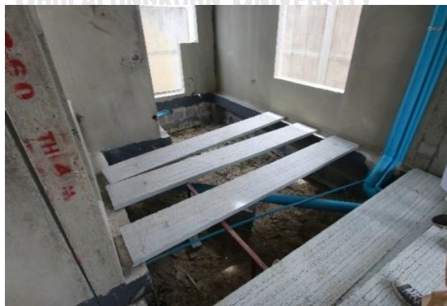
ภาพที่ 89 งานที่ 4 ติดตั้งพื้น ชั้นล่าง บริษัท โลฟ แอนด์ สีฟวี่ จำกัด
