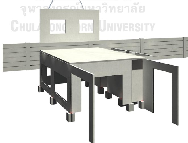
ภาพที่ 85 จำลองงานติดตั้งชิ้นส่วนผนังคอนกรีตสำเร็จรูป ชั้นบน บริษัท ไลฟ์ แอนด์ ลีฟวิ่ง จำกัด
