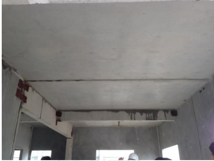
ภาพที่ 92 งานที่ 2 ติดตั้งชิ้นส่วนคานและพื้น ชั้นบน บริษัท พกษา โฮลดิ้ง จำกัด (มหาชน)
