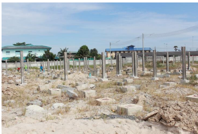
ภาพที่ 21 งานหล่อฐานตอม่อ บริษัท โลฟ แอนด์ ลีฟวิ่ง จำกัด
