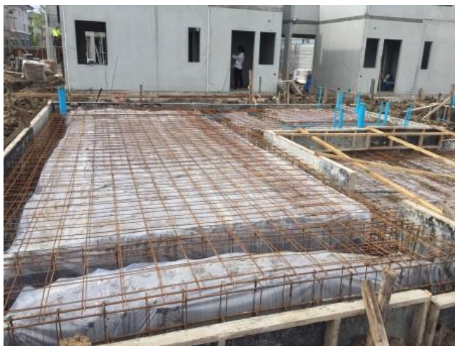
ภาพที่ 76 การเตรียมพื้นคอนกรีตหล่อทับที่ ชั้นล่าง บริษัท พกษา โฮลดิ้ง จำกัด (มหาชน)
