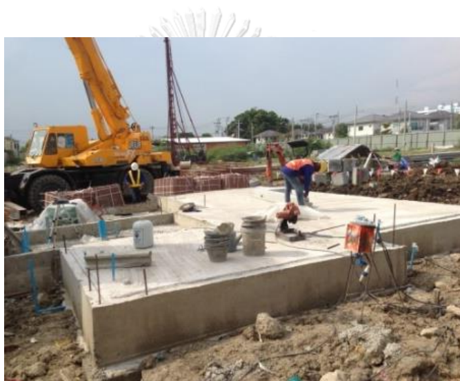
ภาพที่ 90 งานที่ 4 เทพื้นคอนกรีตหล่อกับที่ ชั้นล่าง บริษัท พุกษา โฮลดิ้ง จำกัด (มหาชน)
