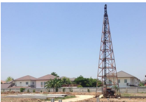
ภาพที่ 20 งานตอกเสาเข็ม บริษัท ไลฟ แอนด์ ลีฟวิ่ง จำกัด
