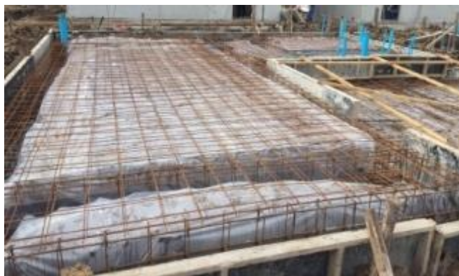
ภาพที่ 95 งานเตรียมเทคอนกรีต ชั้นล่าง บริษัท พกษา โฮลดิ้ง จำกัด (มหาชน)
