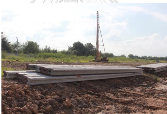
ภาพที่ 19 เตรียมตอกเสาเข็ม บริษัท ไลฟ แอนด์ ลีฟวิ่ง จำกัด
