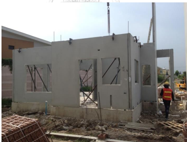
ภาพที่ 30 การติดตั้งผนังคอนกรีตสำเร็จรูป ชั้นล่าง ของบริษัท พกษา โฮลดิ้ง จำกัด (มหาชน)
