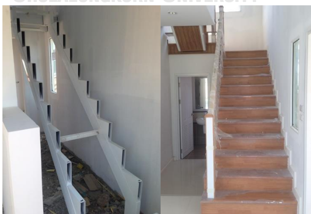
ภาพที่ 48 งานติดตั้งบันได
