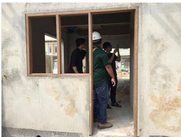
ภาพที่ 45 งานติดตั้งวงกบไม้ประตู-หน้าต่าง บริษัท โลฟ แอนด์ ลีฟวิ่ง จำกัด
