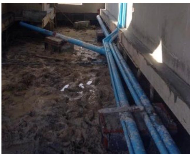
ภาพที่ 35 การเดินท่องานเดินท่องานระบบใต้พื้น ชั้นล่าง บริษัท โลฟ แอนด์ ลีฟวิ่ง จำกัด
