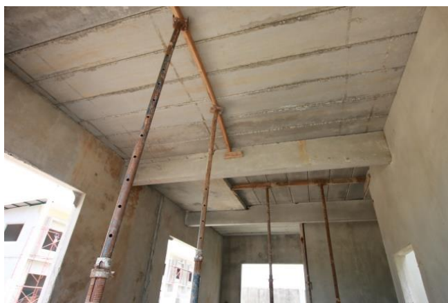
ภาพที่ 31 การติดตั้งชิ้นส่วนคาน และพื้นคอนกรีตสำเร็จรูป ชั้นบน บริษัท ไลฟ แอนด์ ลีฟวิ่ง จำกัด
