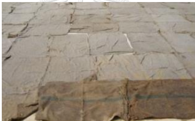
ภาพที่ 96 งานการบ่มคอนกรีตพื้นคอนกรีตหล่อในที่ บริษัท พกษา โฮลดิ้ง จำกัด (มหาชน)
