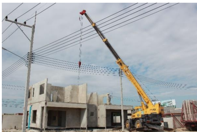
ภาพที่ 33 การติดตั้งผนังคอนกรีตสำเร็จรูป ชั้นบน บริษัท โลฟ แอนด์ ลีฟวิ่ง จำกัด
