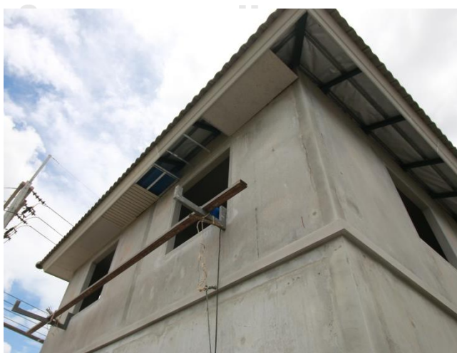
ภาพที่ 54 งานติดตั้งฝ้าเพดานภายนอก บริษัท พลุกษา โฮลดิ้ง จำกัด (มหาชน)
