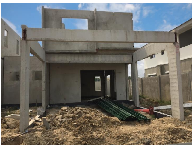
ภาพที่ 39 การปิดรอยต่อและเก็บงานปูน บริษัท ไลฟ์ แอนด์ ลีฟวิ่ง จำกัด
