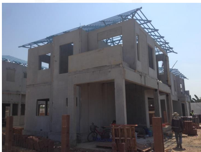
ภาพที่ 42 โครงหลังคาเหล็กชุบสังกะสีสำเร็จรูป บริษัท พกษา โฮลดิ้ง จำกัด (มหาชน)
