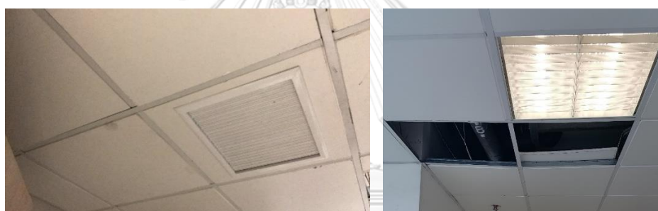
รูปที่ 18 ตัวอย่างข้อบกพร่องที่มีข้อขัดแย้งที่พบบริเวณฝ้า (ซ้าย) เก็บงานโครงคร่าว (ขวา) ไม่ได้ปิดแผ่นฝ้า
