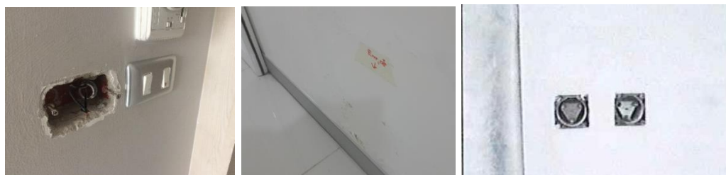
รูปที่ 19 ตัวอย่างข้อบกพร่องที่มีข้อขัดแย้งที่พบบริเวณพื้น (ซ้าย) เอาเล็ตไม่เรียบร้อย (กลาง) ผนังเป็นรอย (ขวา) ฝาครอบเอาต์เล็ตหาย
