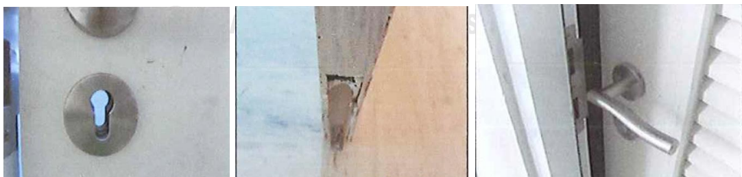
รูปที่ 16 ตัวอย่างข้อบกพร่องที่มีข้อขัดแย้งที่พบบริเวณประตูหรือหน้าต่าง (ซ้าย) ไม่มีใส่กุญแจ (กลาง) ไม่ได้ติดตั้งกลอนประตู (ขวา) ประตูปิดได้ไม่สนิท
