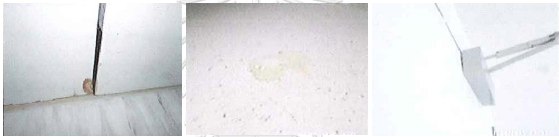
รูปที่ 23 ตัวอย่างข้อบกพร่องที่มีข้อขัดแย้งที่เกิดขึ้นในพื้นที่เชิงเดี่ยว (ซ้าย) ประตูถลอก (กลาง) พื้นมีรอบคราบขาว (ขวา) ไข้คเสี้ยน
