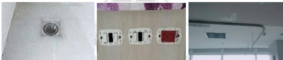
รูปที่ 12 แสดงตัวอย่างของหายในโครงการ (ซ้าย) ฝาห้องน้ำทิ้งหาย (กลาง) ฝาเอาท์เล็ทหาย (ขวา) ฝ้าม่านหาย
