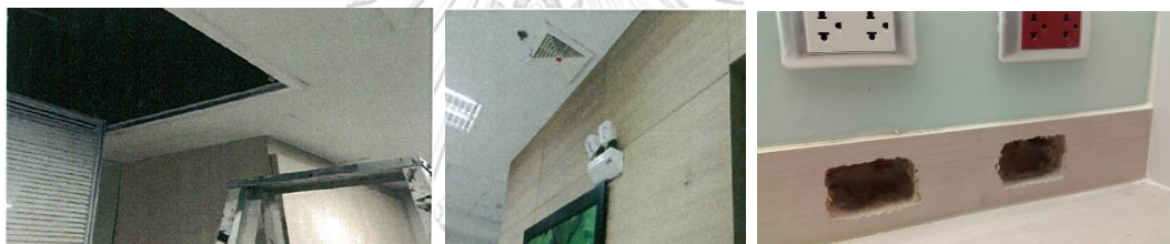
รูปที่ 14 ตัวอย่างของอยู่ผิดตำแหน่งในโครงการ (ซ้าย) ช่องช่องบำรุงรักษาระบบปรับอากาศกับตู้ติดตามอยู่ในตำแหน่งซ้อนทับกัน (กลาง) พัดลมดูดอากาศกับตู้ติดตามอยู่ในตำแหน่งซ้อนทับกัน (ขวา) เอาท์เล็ตอยู่ผิดตำแหน่ง
