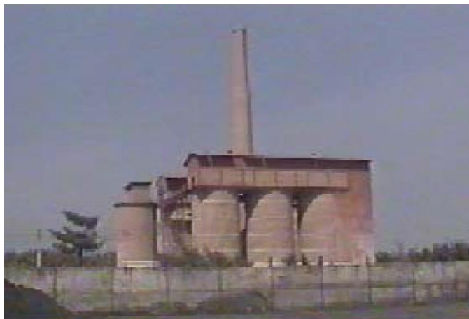
ภาพที่ 2.18 เตาตั้งแบบ Mixed Feed (นนทชัย อึ้งชัยพาณิชย์, 2546)
