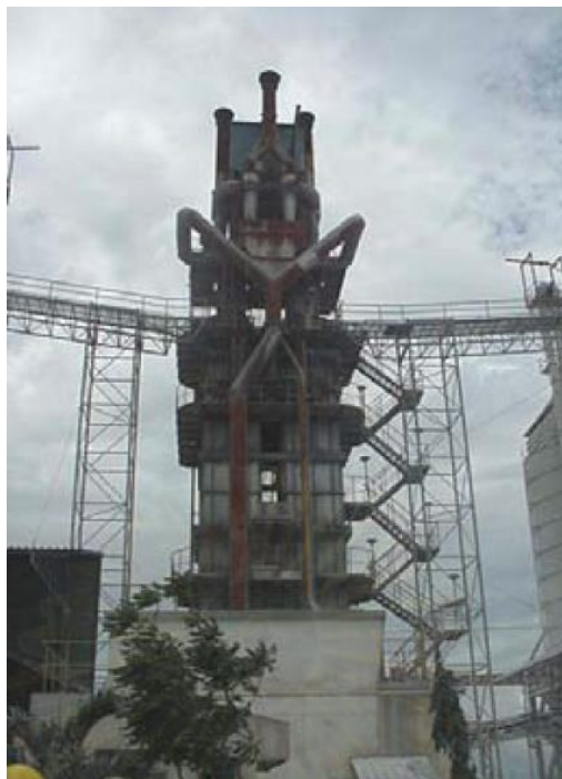
ภาพที่ 2.17 เตาตั้ง (Vertical Shaft Kiln) (นนทชัย อึ้งชัยพาณิชย์, 2546)
