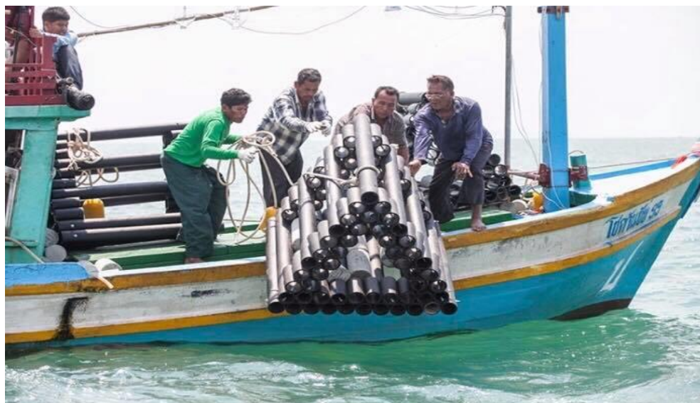
ภาพที่ 25 การนำบ้านปลาจากท่อ PE 100 ไปวางในทะเล (บุญธรรม รุจิวงศ์, 2560)
