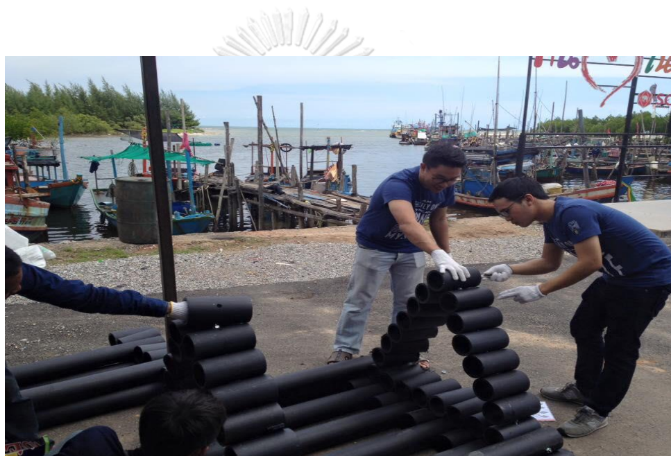
CHULALONGKORN UNIVERSITY ภาพที่ 22 การประกอบในส่วนหลังคาของบ้านปลาจากท่อ PE 100 (บุญธรรม รุจิวงศ์, 2560)
