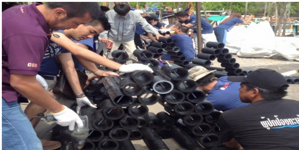
ภาพที่ 23 การประกอบในส่วนหลังคาของบ้านปลาจากท่อ PE 100 (บุญธรรม รุจิวงศ์, 2560)
