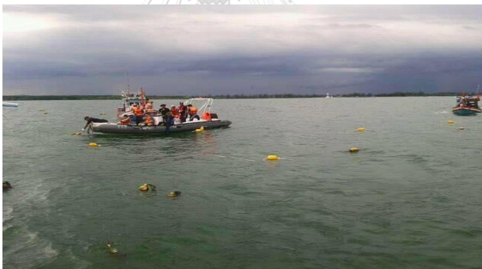
ภาพที่ 26 การนำบ้านปลาจากท่อ PE 100 ไปวางในทะเล (บุญธรรม รุจิวงศ์, 2560)
