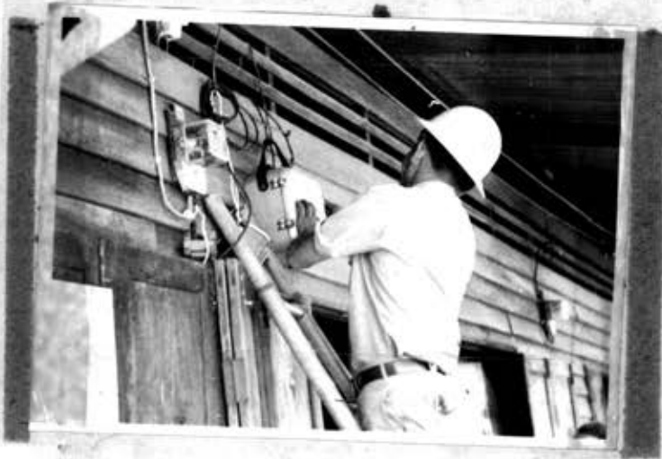
รูปที่ 3.3.8 หลังจากการวางทุบเรียบร้อย ปิดฝาหุ้ม Screw ให้แน่น
