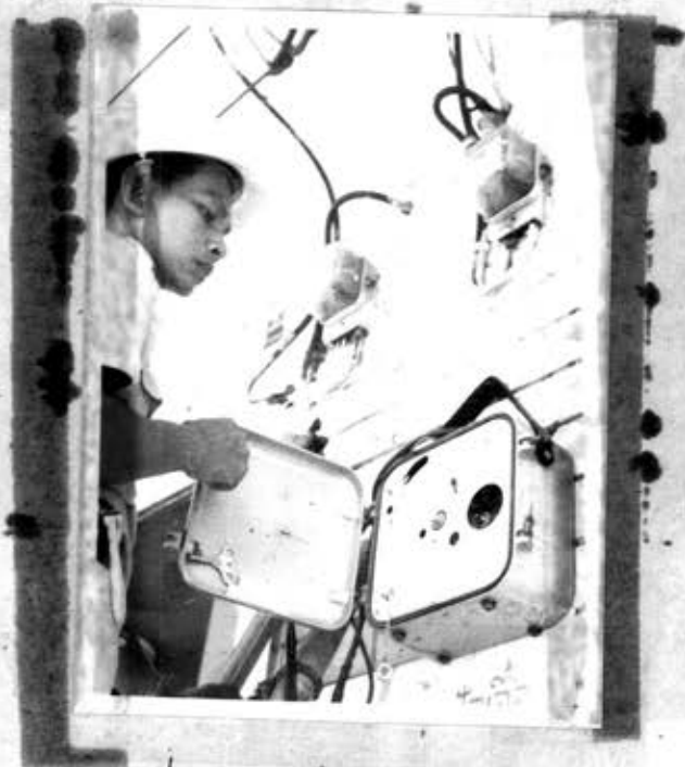
รูปที่ 3.3.6 การตรวจสอบ
