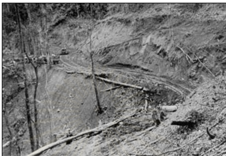
รูปภาพที่ 3.1 แสดงการก่อสร้างถนนพม่า
