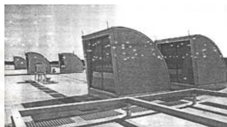
รูปภาพที่ ๗9 แสดงช่องแสงแบบ Light Scoops
