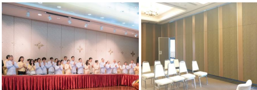
ภาพที่ 5.12 ผนังตกแต่งบุฟองยางกรุผ้า ผนัง ภายในห้องอเนกประสงค์กรณีศึกษา
