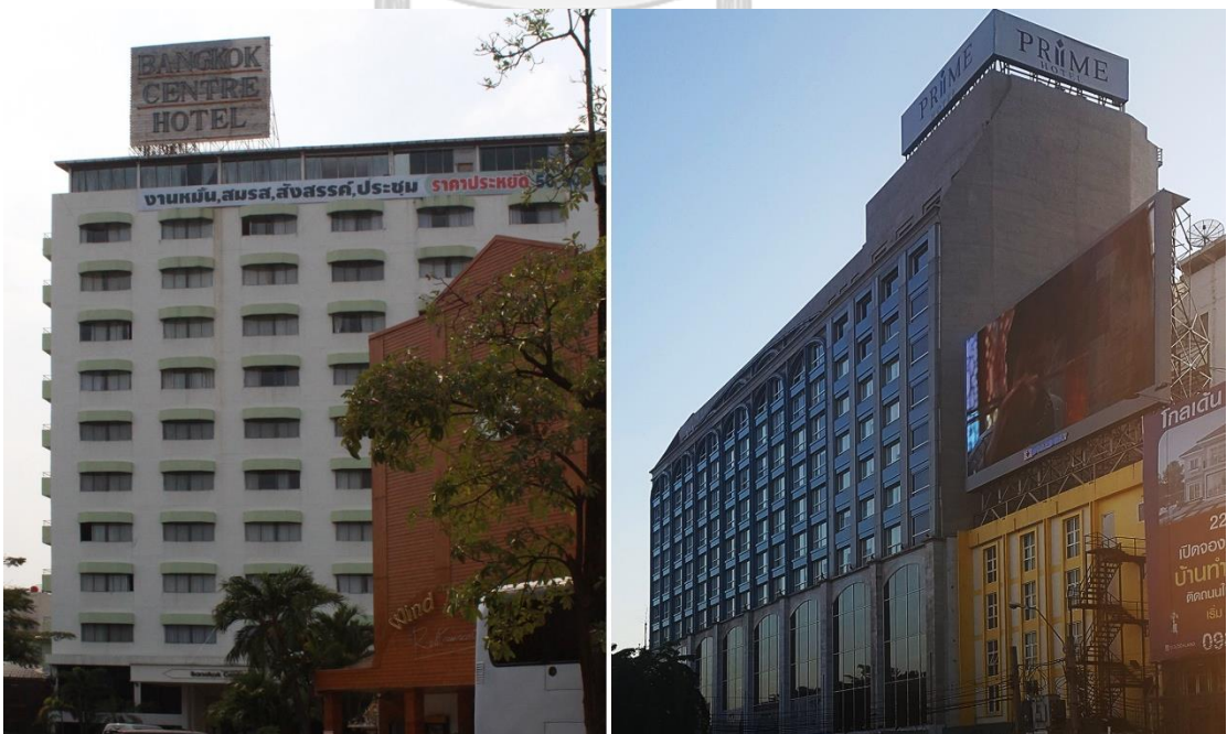
รูปภาพที่ 14 ตัวอย่างโรงแรมที่มีลักษณะเป็นอาคาร 11-15 ชั้น
