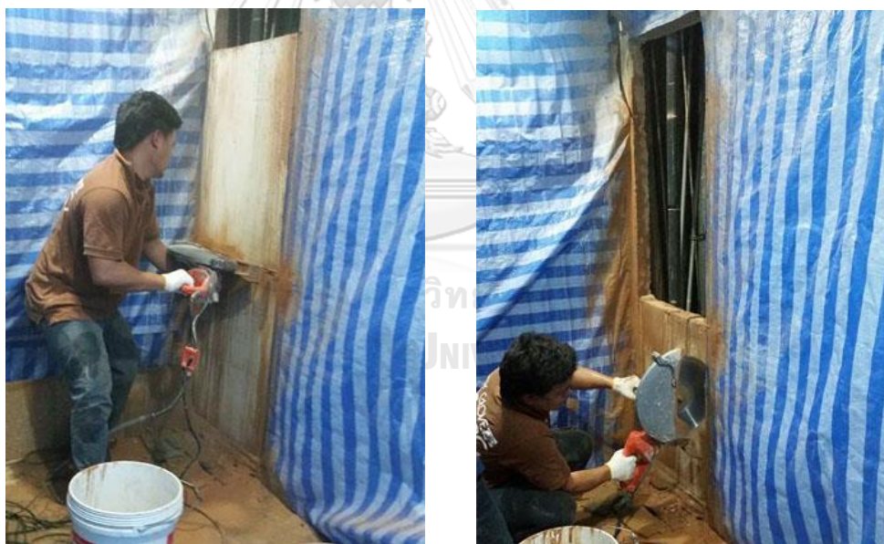
รูปที่ 7 การตัดผนังด้วยเลื่อยไฟฟ้า
