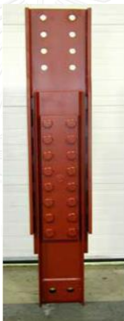
รูปที่ 2.2 ลักษณะของ Pall friction damper
